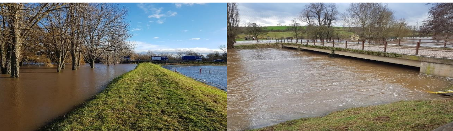
Abbildung 1: Winterhochwasser 2023/24 der Helme im Flussbereich Sangerhausen (Fotos LHW, 2024).
