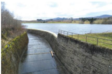
Blick über die Hochwasserentlastungsanlage zum Stauraum am 28.12.2023, Beckenpegel 466,30 müNNH (-0,20 m unter Vollstau, Inhalt 4,35 Mio m<sup>3</sup>)
