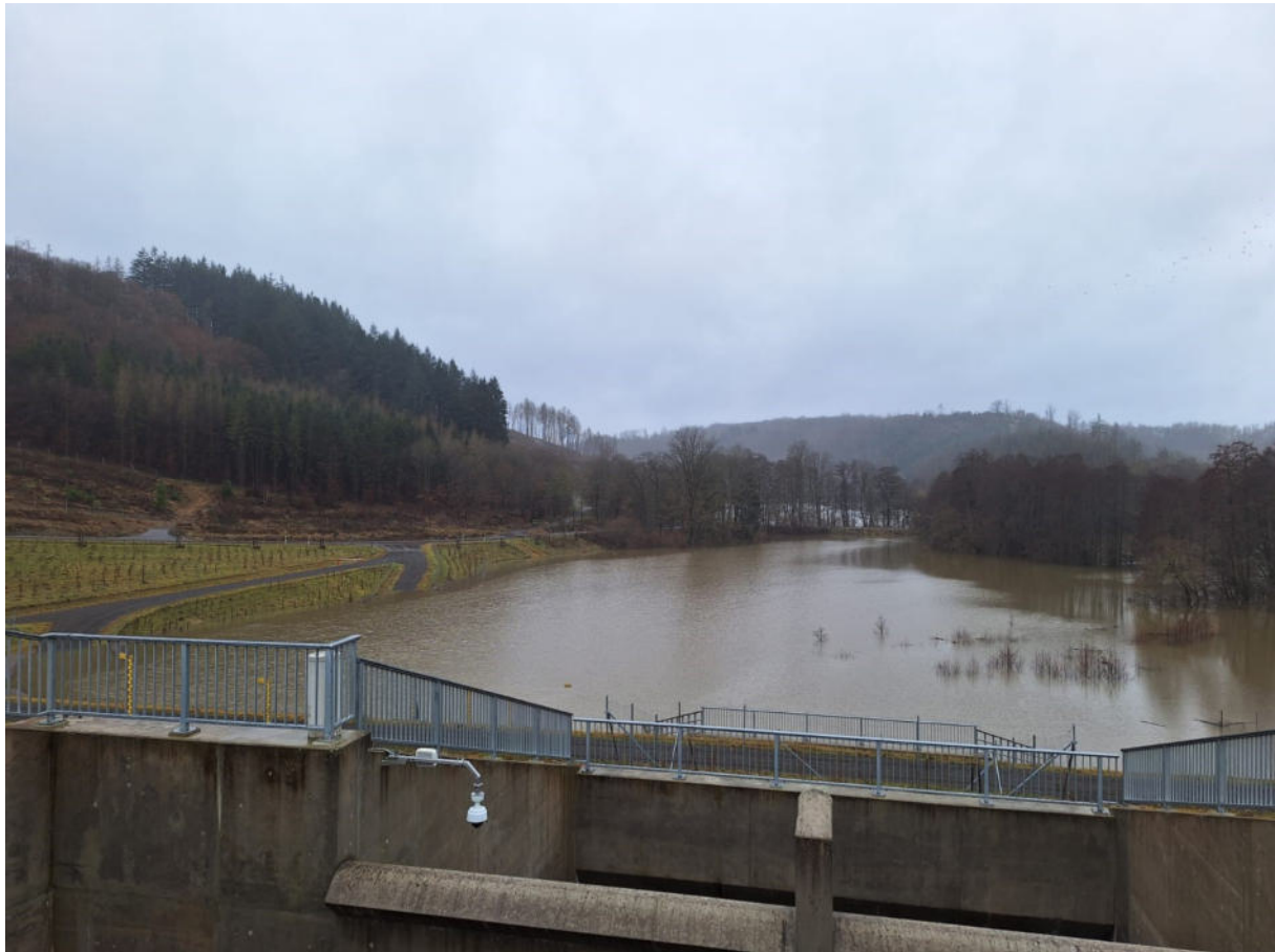
Abbildung 26 HRB Wippra: Blick vom Absperrbauwerk zum Stauraum (24.12.23, Inh.: ca. 0,35 Mio. m 3 )
