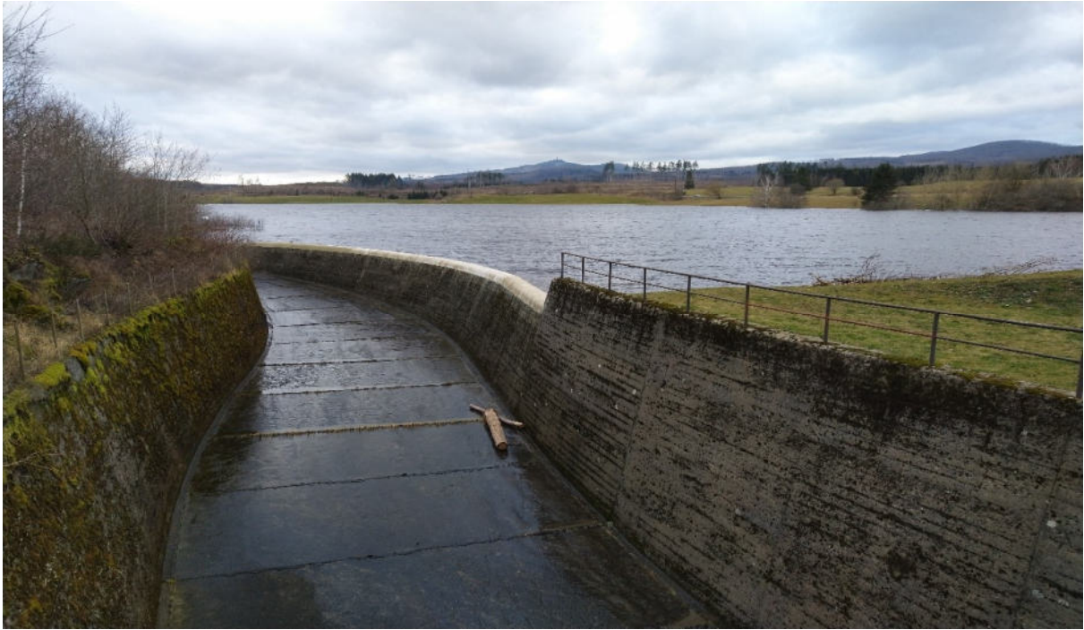
Abbildung 18 HWSB Kalte Bode: Blick über die Hochwasserentlastungsanlage zum Stauraum am 28.12.2023, Beckenpegel: 466,30 müNHN (-0,20 m unter Vollstau, Inhalt: 4,35 Mio. m 3 )
