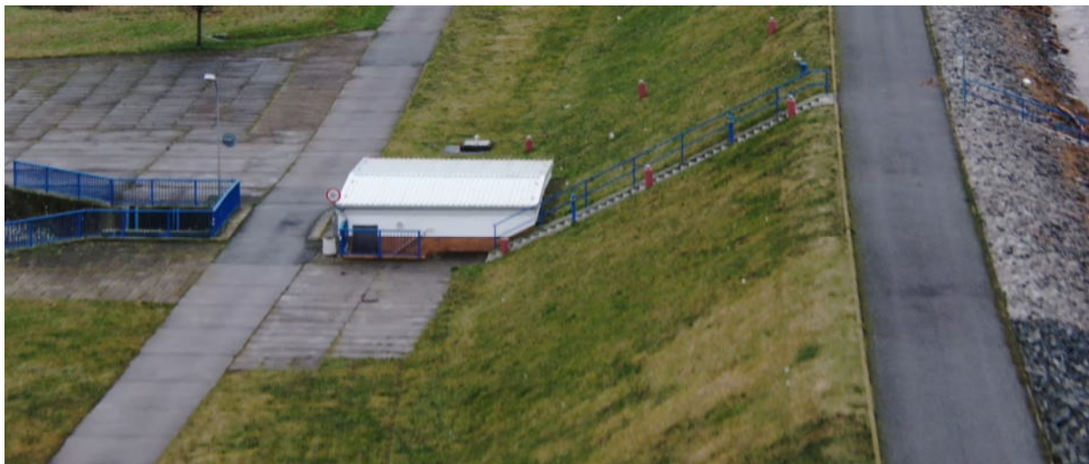
Abbildung 42 TS Kelbra, Sickerlinienmesstellen am BW I
