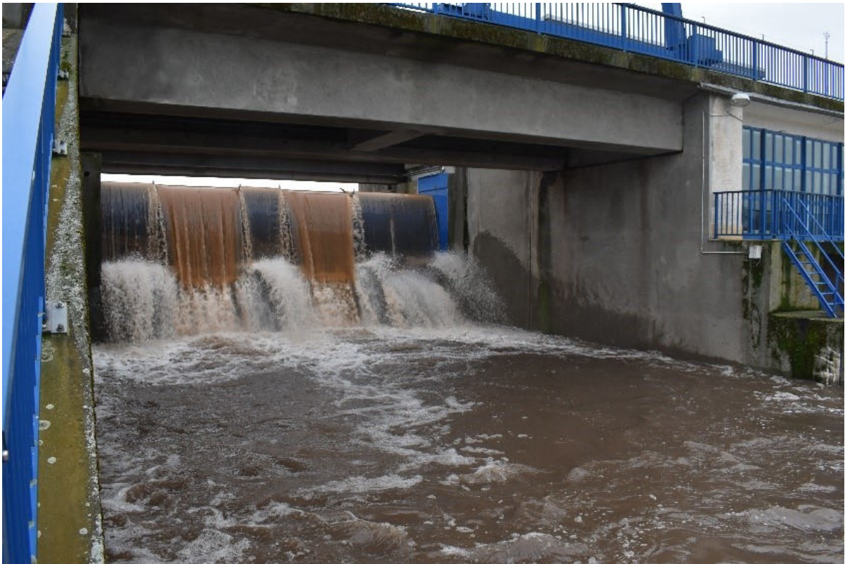
Abbildung 36 Bauwerk II, Überlauf über die Fischbauchklappen bei Vollstau am 27.12.2023
