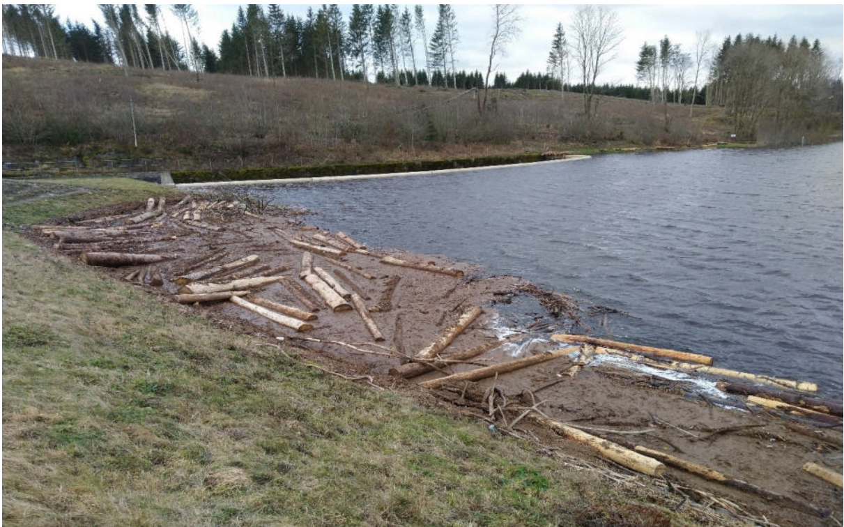
Abbildung 19 HWSB Kalte Bode: Blick zur Hochwasserentlastungsanlage am 28.12.2023 (Zeitpunkt wie Abbildung 18)
