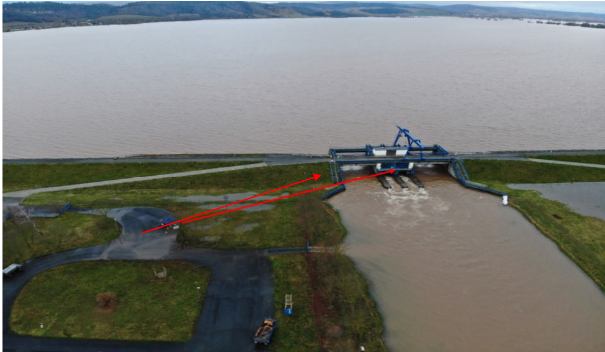
Abbildung 47 Permanentüberwachung BW II durch THW (Quelle: THW)
