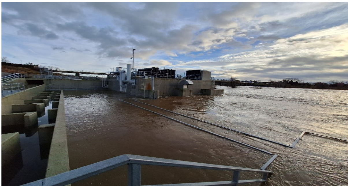
Abbildung 30 Muldestausee: Blick zur WKA am 26.12. bei einer Durchflussmenge von 670 m 3 /s bis 690 m 3 /s (Unterwasserpegel bei 77,80 müHN, normal 73,50 – 73,70 müHN)
