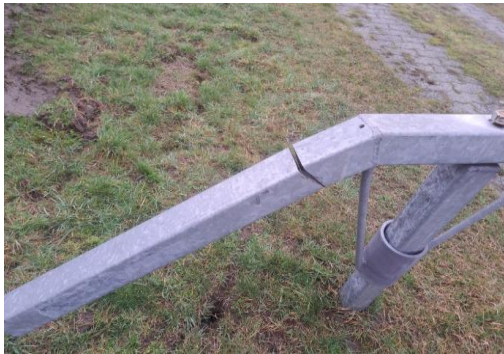
Eine der beschädigten Deichschranken
