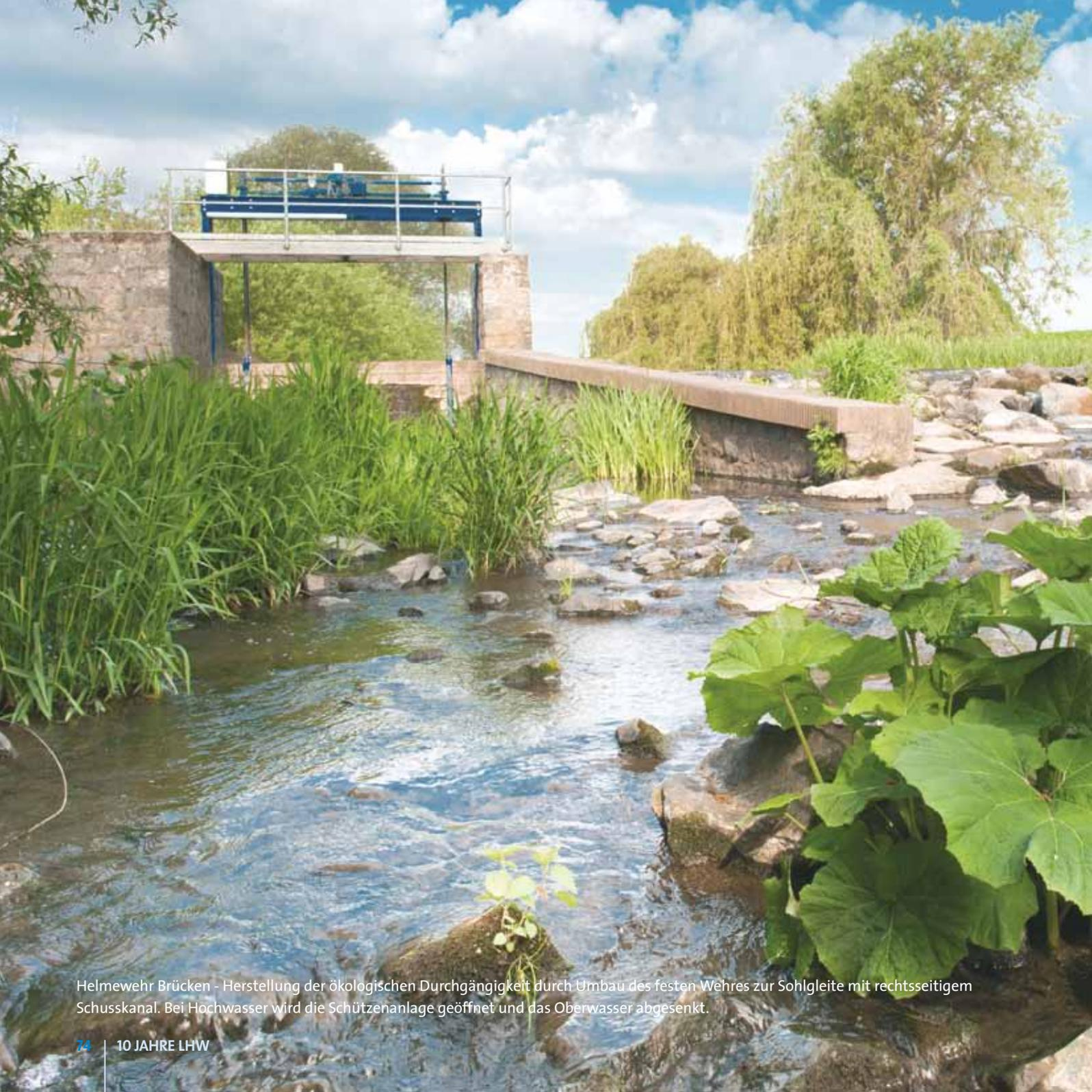
Helmwehr Brücken - Herstellung der ökologischen Durchgängigkeit durch Umbau des festen Wehres zur Sohlgleite mit rechtsseitigem Schusskanal. Bei Hochwasser wird die Schützenanlage geöffnet und das Oberwasser abgesenkt.
