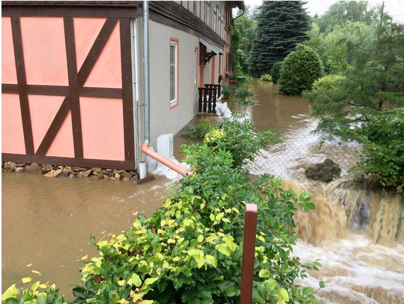
Ehemalige Mühle von beiden Seiten geflutet aufgrund Überströmung des Leitdeiches und des Mühlengrabenabschlages von der Holtemme am Freibad
