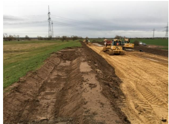
Abbildung 2 - Einbau Stützkörper (02/2020)
