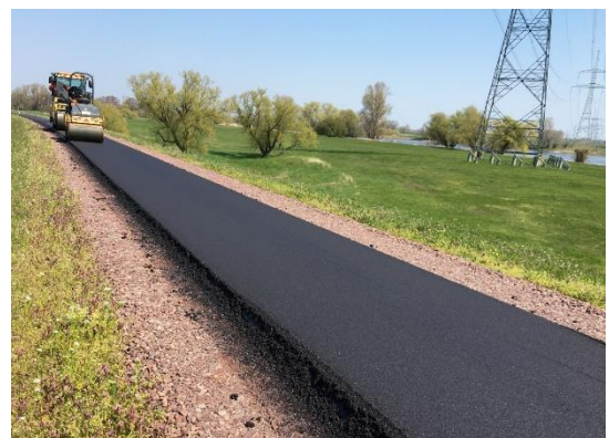
Abbildung 3 - Einbau Asphaltdeckschicht im Deichkontrollweg (04/2021)
