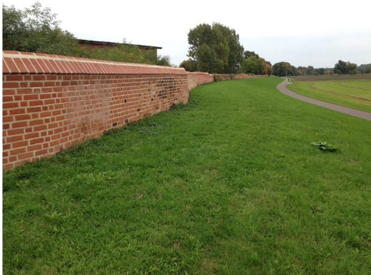
Abbildung 2 - Deich im Bestand mit integrierter Klostermauer bei Deich-km 40+775 (Foto: LHW)
