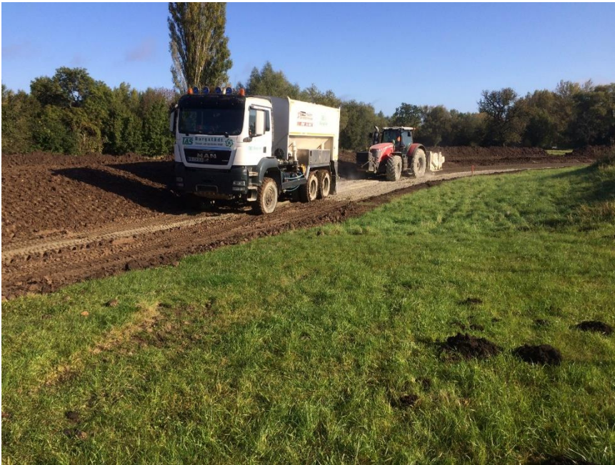
■ Abbildung 3: Einbau Bodenstabilisierung mit Bindemitteln für Deichverteidigungsweg
