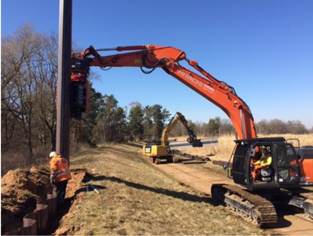
Abbildung 2: Während der Bauausführung – Einbringen der Spundwand
