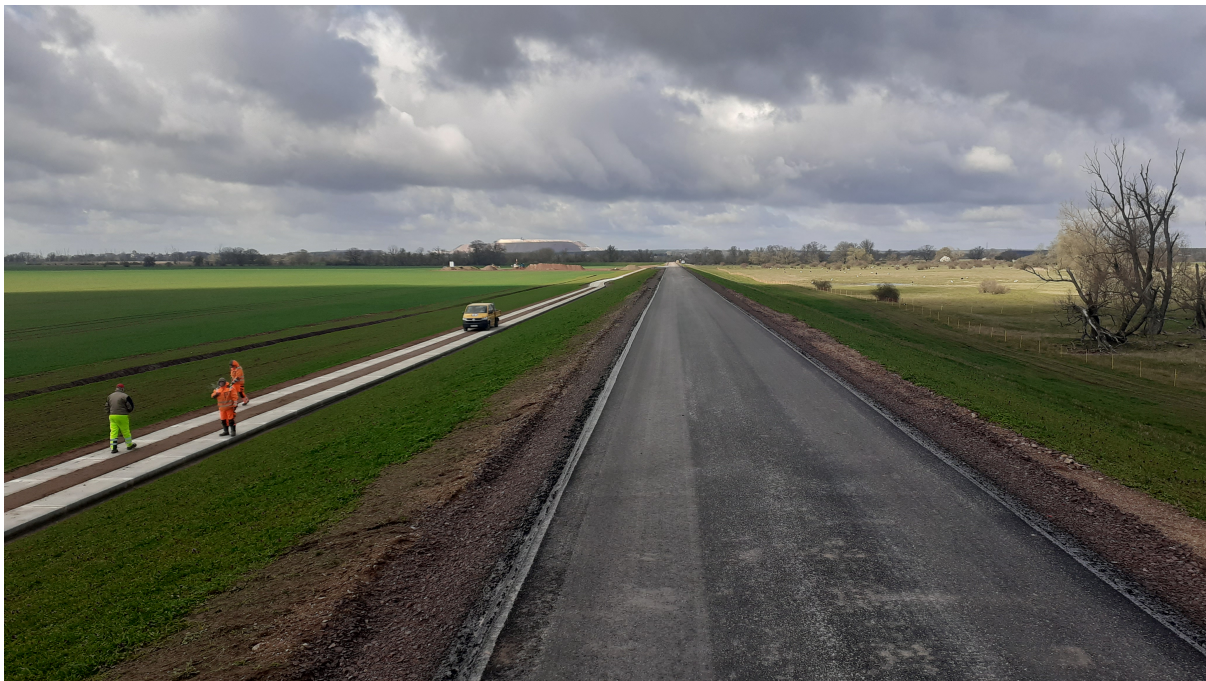
Abbildung 3 - Deich kurz vor Fertigstellung 28.03.2023
