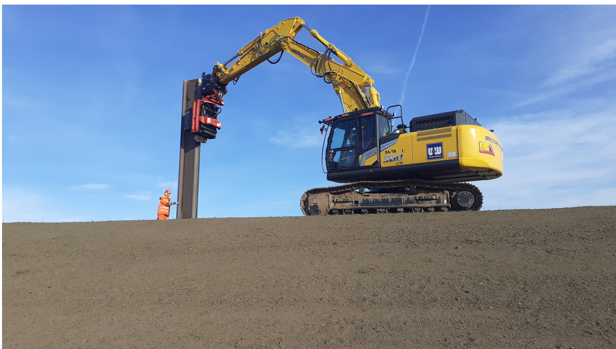
Abbildung 2 - Einbringen der Spundwand 08.11.2022
