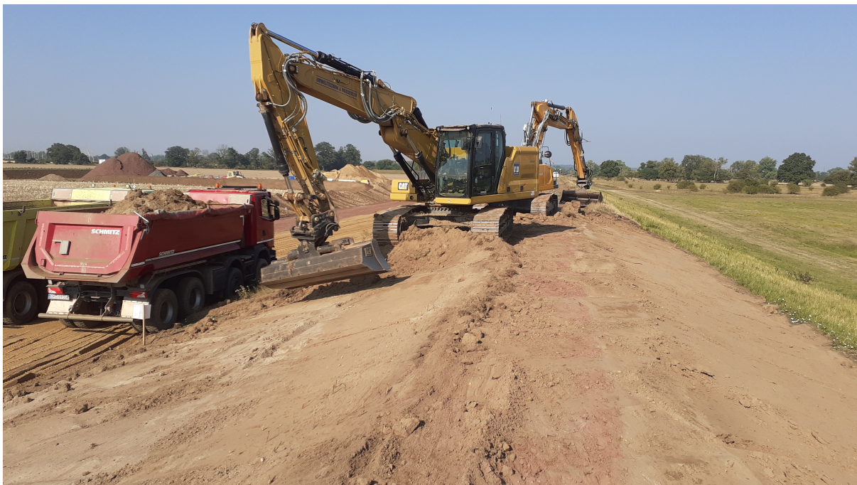
Abbildung 1 - Deich im Bau 16.08.2022
