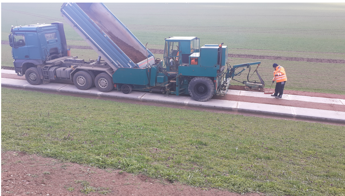
Abbildung 4 - Herstellung des Schotterrasens am Betonspurweg 28.03.2023
