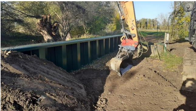
Abbildung 3 – Böschungprofilierung (11/2020)
