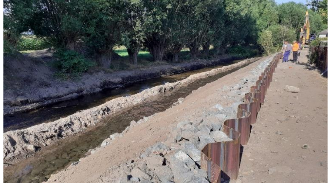
Abbildung 2 – Einbringung der Spundwände (07/2020)
