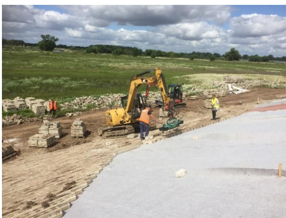
Abbildung 3 – Wasserseitige Deichböschung: Einbau des vorher ausgebauten Wasserbaupflasters mit dem Greifer (07/2020)
