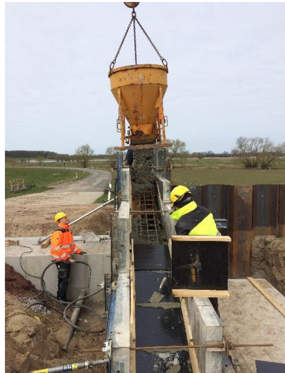
Abbildung 2 – Deichscharte: Betonage der Flügelwand (03/2020)
