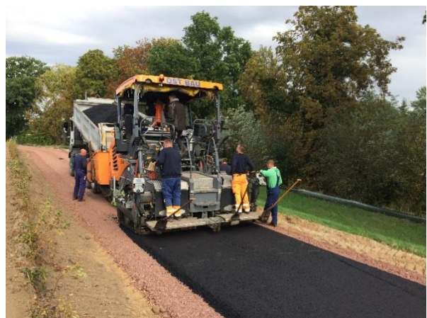
Abbildung 4 – Deichverteidigungsweg: Einbau Asphalttragschicht mit dem Asphaltfertiger (09/2020)
