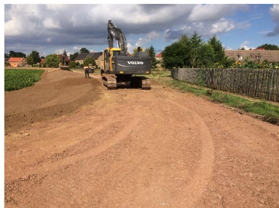
Abbildung 2 - Andecken von Oberboden (09/2020)
