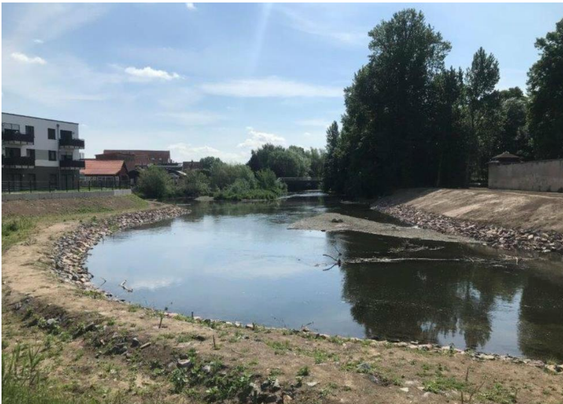
Abbildung 2: Blick auf die Bode in Oschersleben ohne Einschränkungen des Abflussquerschnitts nach dem Rückbau des Wehrs
