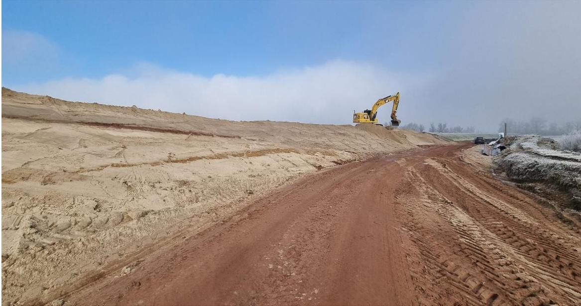
Abbildung 3 – Einbau Stützkörpermaterial November 2022, Quelle: LHW
