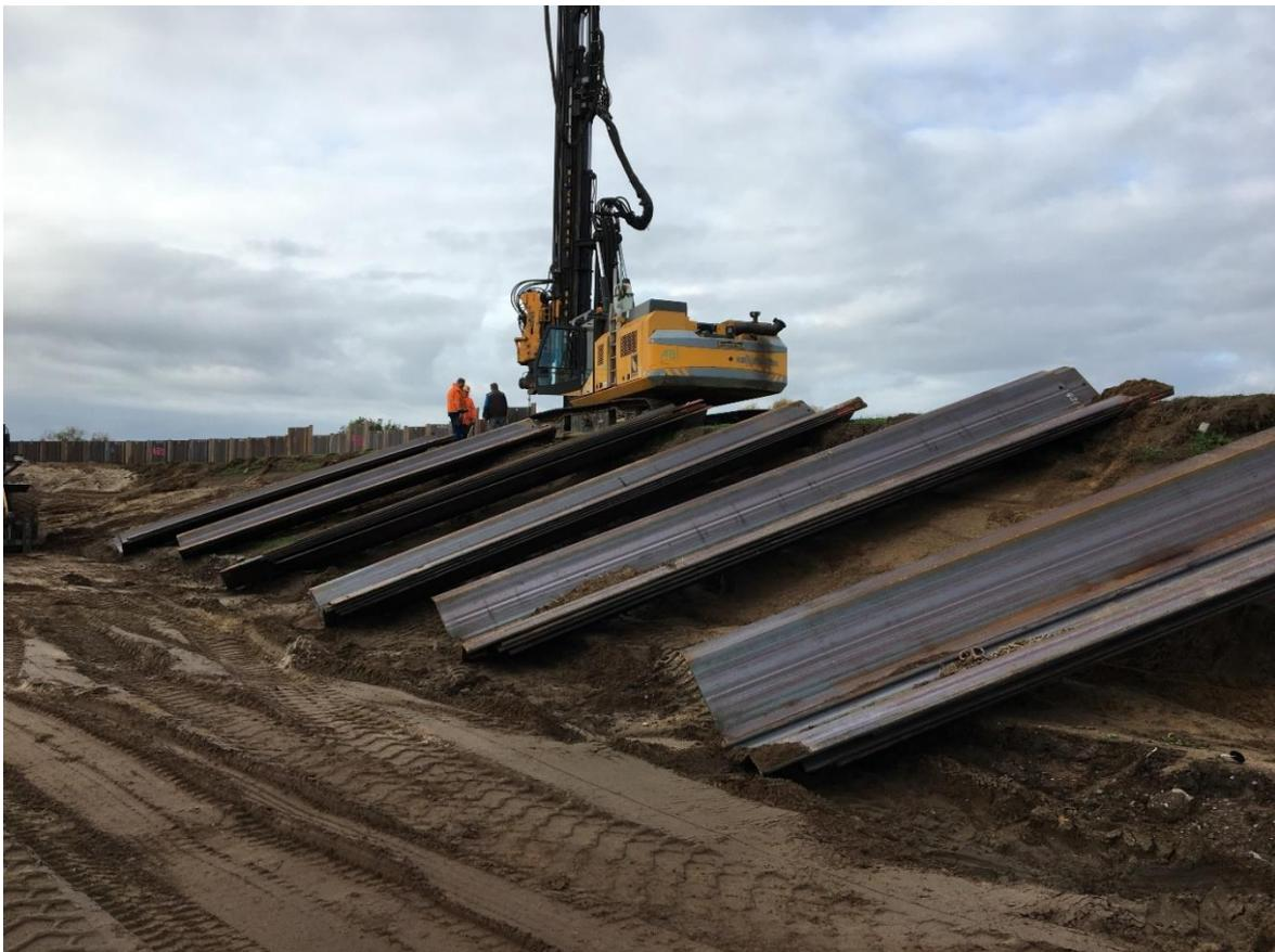
Abbildung 2 – Einbau Stahlpundwand Oktober 2022, Quelle: LHW
