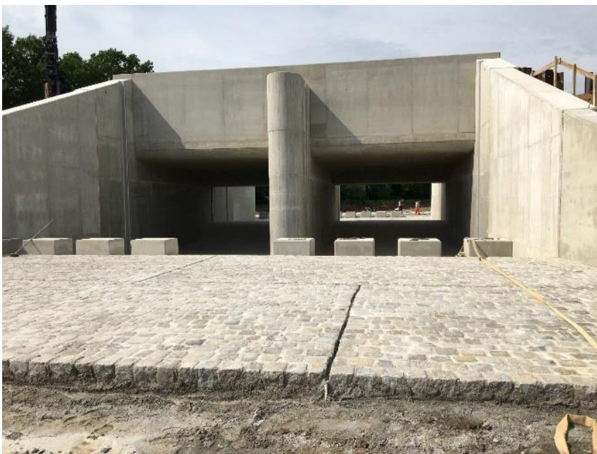
Abbildung 2 - Bauzustand Auslaufbauwerk aus Richtung Flutpolder
