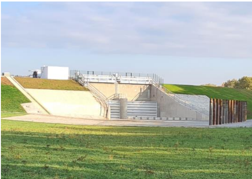
Abbildung 1 - Auslaufbauwerk nach baulicher Fertigstellung
