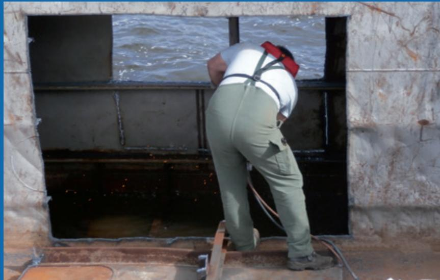
**Abb. 15** Ausbrennen der Flußöffnungen des Schubleichters (Foto: WSA MD)
