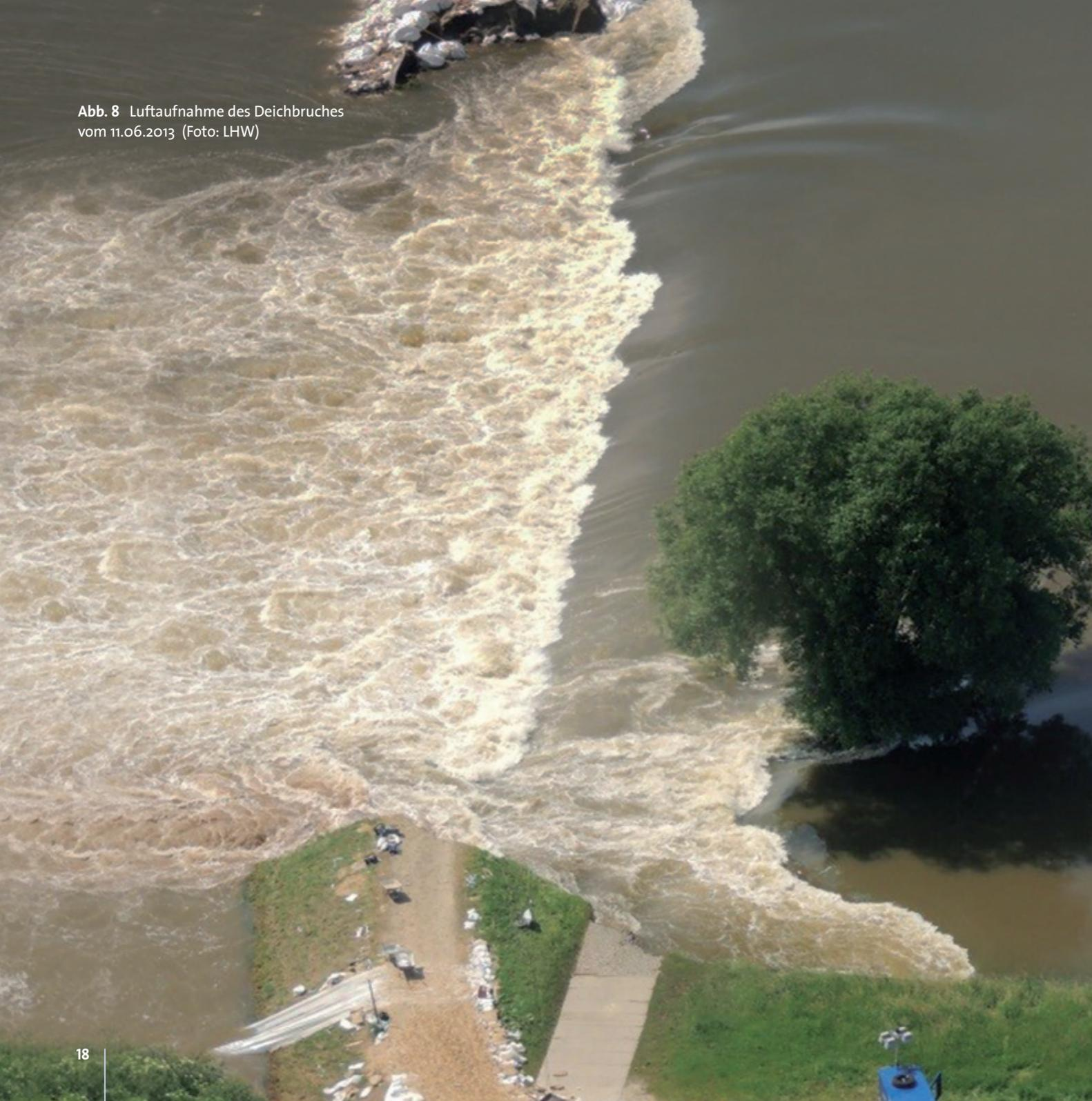
Abb. 8 Luftaufnahme des Deichbruches vom 11.06.2013 (Foto: LHW)
