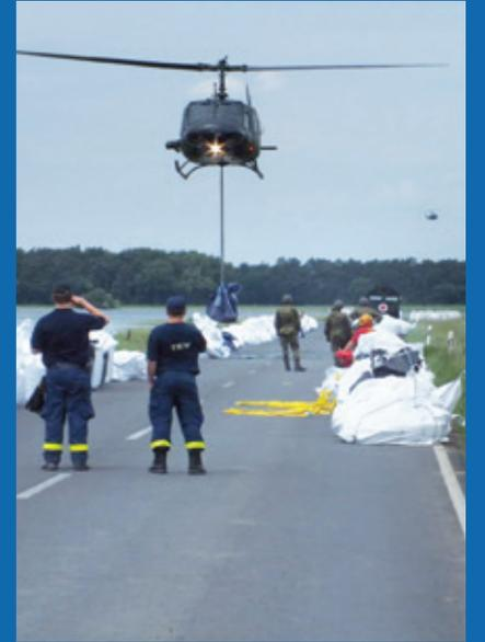
Abb. 14 ... und an der Deichbruchstelle abgeworfen (Foto: LHW)
