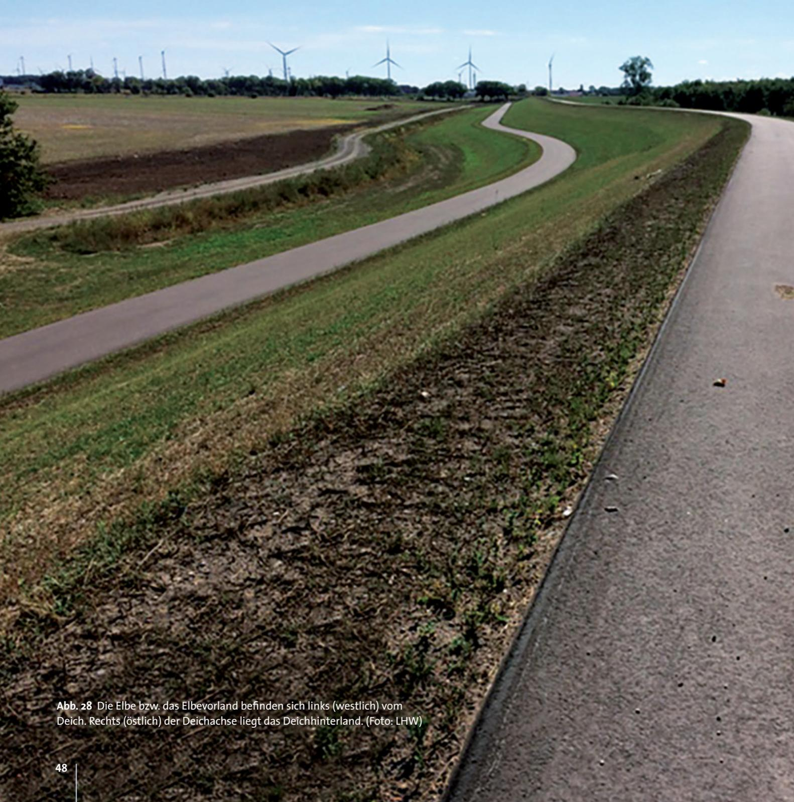
Abb. 28 Die Elbe bzw. das Elbevorland befinden sich links (westlich) vom Deich. Rechts (östlich) der Deichachse liegt das Deichhinterland. (Foto: LHW)
