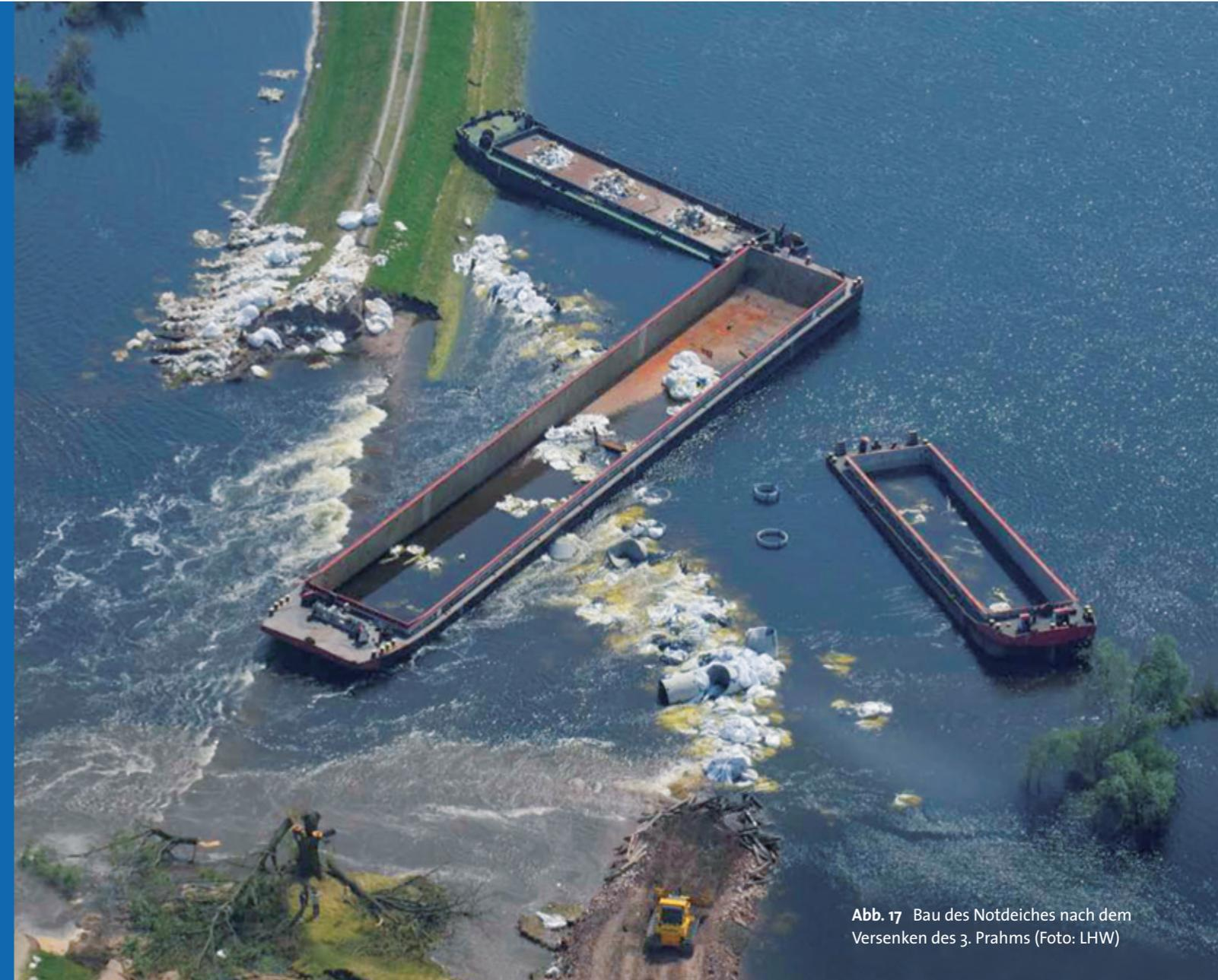
**Abb. 17** Bau des Notdeiches nach dem Versenken des 3. Prahms (Foto: LHW)
