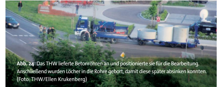
Abb. 24 Das THW lieferte Betonröhren an und positionierte sie für die Bearbeitung. Anschließend wurden Löcher in die Röhre gebort, damit diese später absinken konnten.
