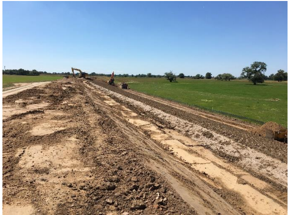
Abbildung 2 – Erhöhung der wasserseitigen Dichtung (07/2019)
