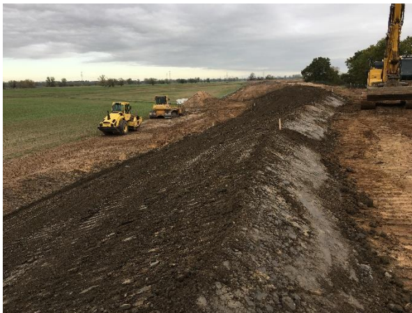
Abbildung 3 - Neubau der wasserseitigen Dichtung (10/2019)
