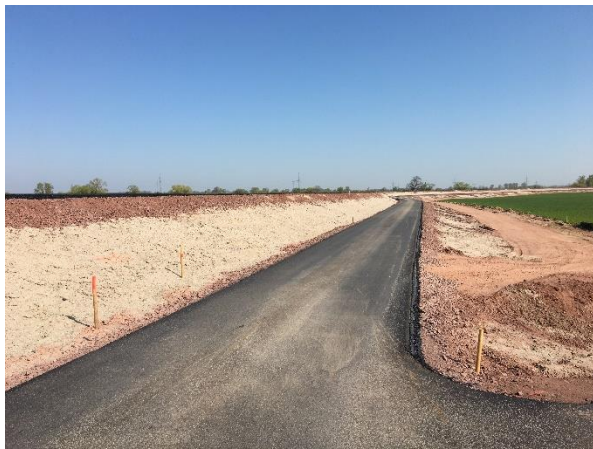
Abbildung 4 – Herstellung Fahrbahn des landseitigen Deichverteidigungsweges (Berme) (04/2020)
