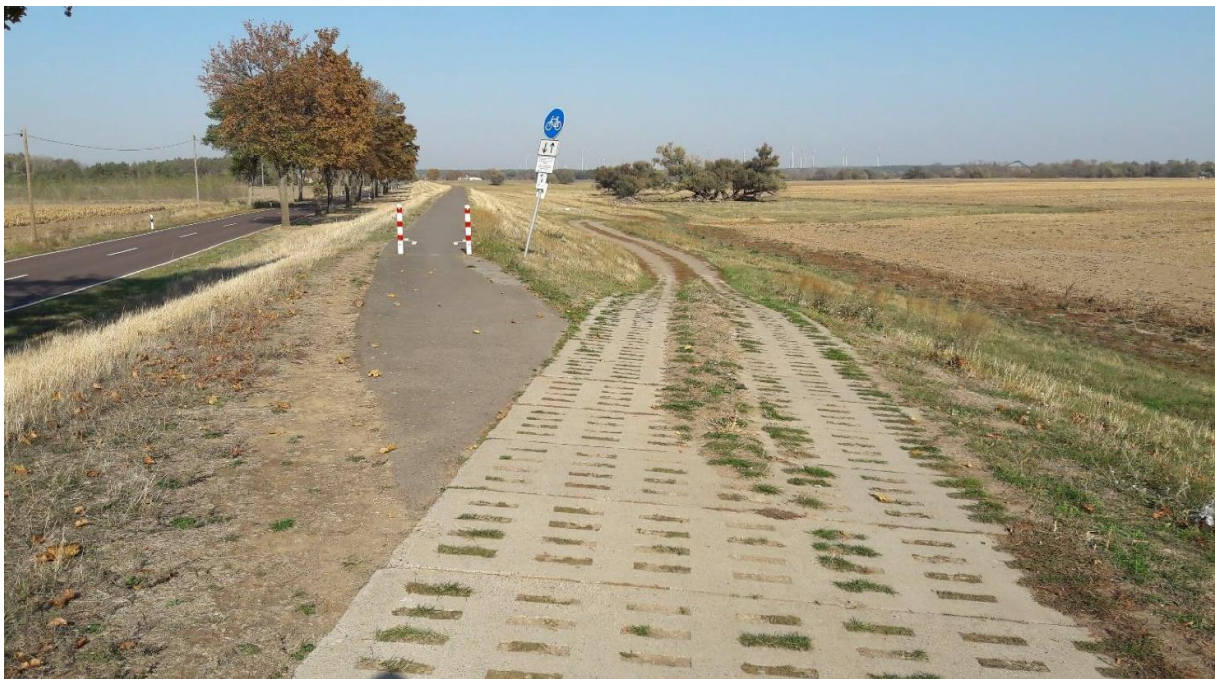
Abbildung 2 - Deich (Bestand) bei Deich-km 0+020 (Foto: PROWA Neuruppin)
