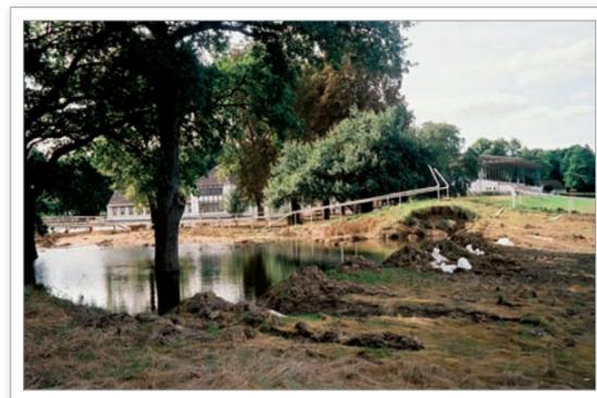
Abb. 4.5: Bruchstelle des Rückstaudeiches der Elbe in Magdeburg-Herrenkrug an den Rennwiesen vom 19. August 2002
