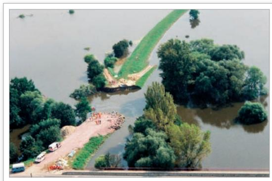
Abb. 4.4: Bruchstelle des rechten Deiches des Elbeumflutkanals bei Heyrothsberge am 22. August 2002. Durch die 40 m breite Lücke wurde eine 10,2 km<sup>2</sup> große Fläche bei Gübs, Wahlitz und Menz überflutet.
