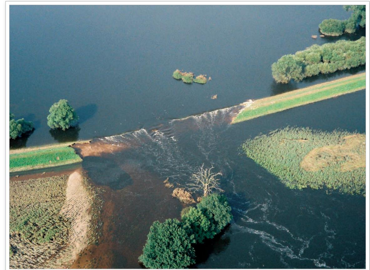
Abb. 5.6: Bruchstelle des linken Elbedeiches bei Seegrehna unterhalb von Wittenberg/L. am 25. August 2002. Durch die Bruchstelle (100 m breite Lücke) wurden bis zu 200 m<sup>3</sup>/s in die überschwemmte Fläche von 50 km<sup>2</sup> abgeleitet.
