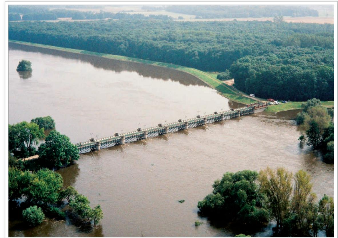
Abb. 6.4: Geöffnetes Pretziener Wehr beim Hochwasser am 22. August 2002
