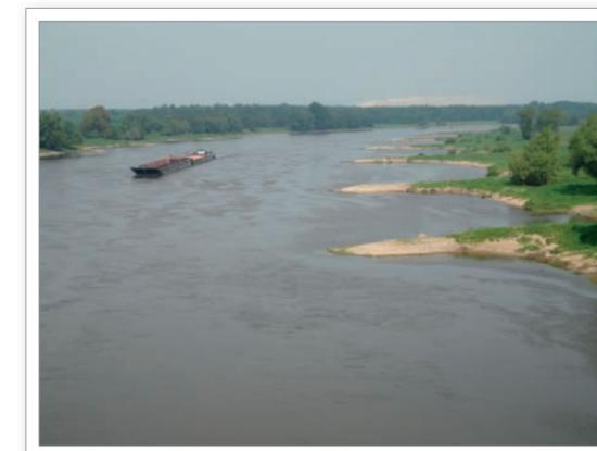
Abb. 9.3: Buhnenfelder am rechten Ufer der Elbe bei Hohenwarthe bei einem Wasserstand von 50 cm unter Mittelwasser
