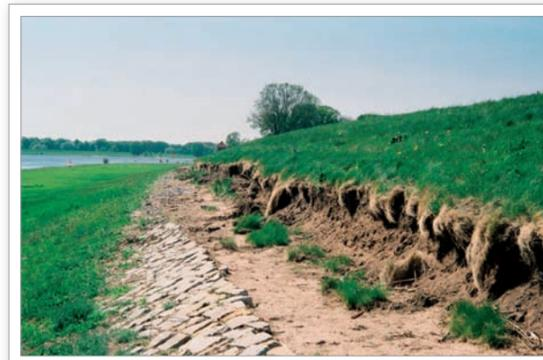
Abb. 8.4: Deichschäden infolge des Eisganges beim Hochwasser im Januar 2003 am rechtsseitigen Elbedeich oberhalb von Müggendorf (Elbe-km 463,7)
