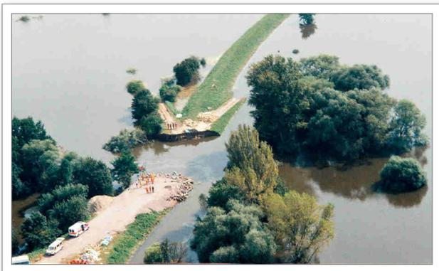
Abb. 4.7: Bruchstelle des rechten Deichs des Elbeumflutkanals bei Heyrothsberge am 22. August 2002. Durch die 40 Meter breite Lücke wurde eine 10,2 Quadratkilometer große deichgeschützte Fläche bei Gübs, Wahlitz und Menz überflutet (Foto: M. Simon)
