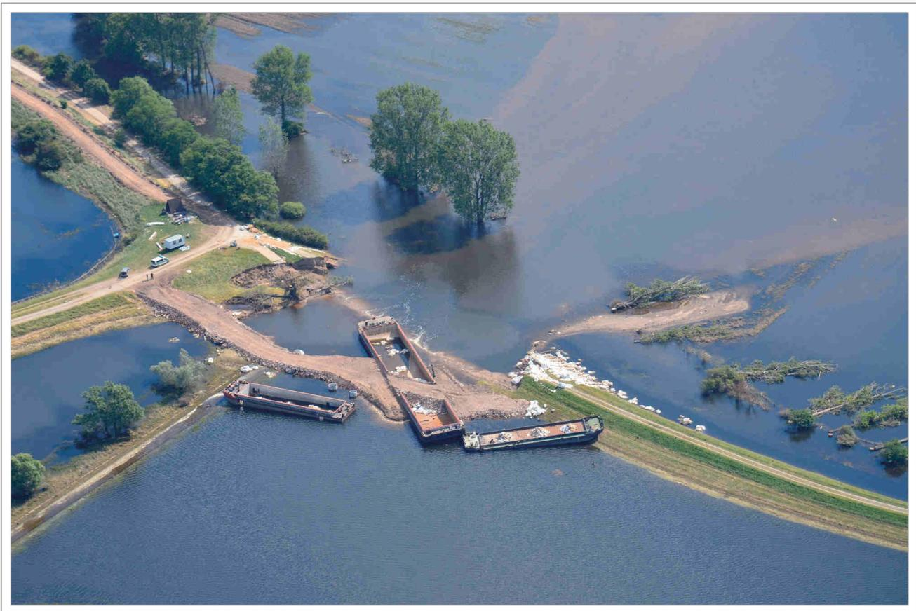
Abb. 6.27: Geschlossene Bruchstelle des Deiches bei Fischbeck durch drei Schubschiffe und weitere Materialien am 22. Juni 2013 (Foto: LHW, St. Müller)
