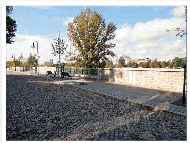
Abb. 4.12: Hochwasserschutzmauer in der Zollstraße mit teilweise integrierten Glaselementen als „Elbeblick“ (Foto: M. Simon)
