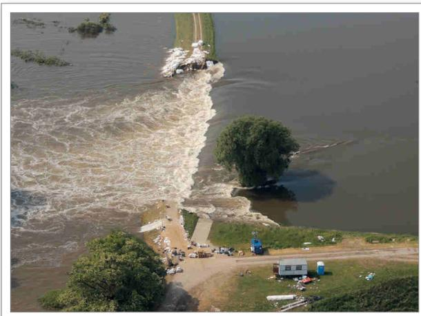
Abb. 6.25: Bruchstelle des Elbedeiches bei Fischbeck am 12. Juni 2013, zwei Tage nach Eintreten des Deichbruches (Foto: R. Jüppner)
