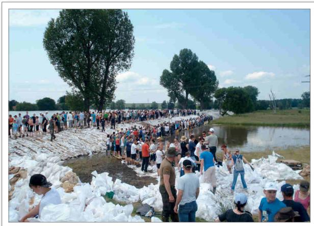
Abb. 6.22: Erhöhung des ehemaligen Eisenbahndammes in Lostau am 9. Juni 2013 zur Sicherung der noch nicht überfluteten Ortsteile von Lostau (Foto: S. Olbrich)
