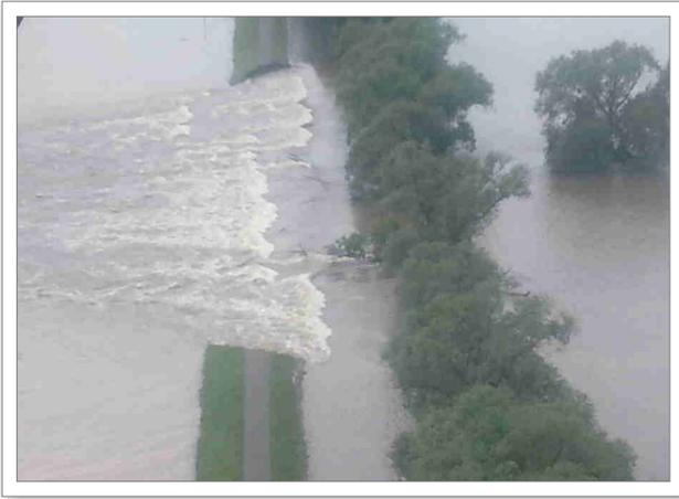
Abb. 6.8: Deichbruch bei Klein Rosenberg/Breitenhagen an der Saale am 9. Juni 2013 (Foto: LHW, Ch. Jung)
