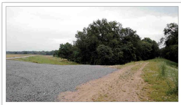
Abb. 5.7: Beginn der Deichrückverlegung bei Elbe-Kilometer 278,25. Rechts ist der Altdeich, links der neue Deich (Foto: M. Simon)
