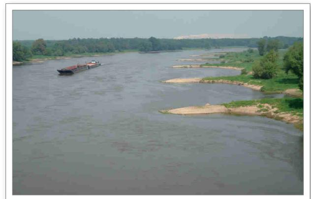
Abb. 10.4: Buhnenfelder am rechten Ufer der Elbe bei Hohenwarthe bei einem Wasserstand von 50 Zentimeter unter Mittelwasser (Foto: M. Simon)
