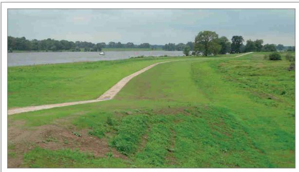
Abb. 5.5: Erster Deichschlitz mit einer Breite von 390 Meter unterhalb des Standortes „Böser Ort“ im August 2011 (Foto: M. Simon)
