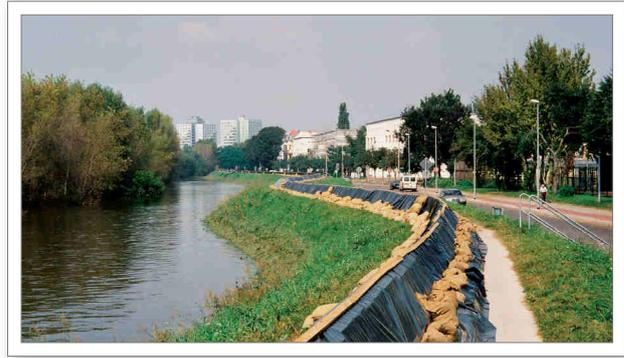
Abb. 6.5: Mobile Hochwasserschutzwände auf dem Deich der Alten Elbe in Cracau am 23. August 2002 bei einem Wasserstand von 575 Zentimeter (Foto: M. Simon)
