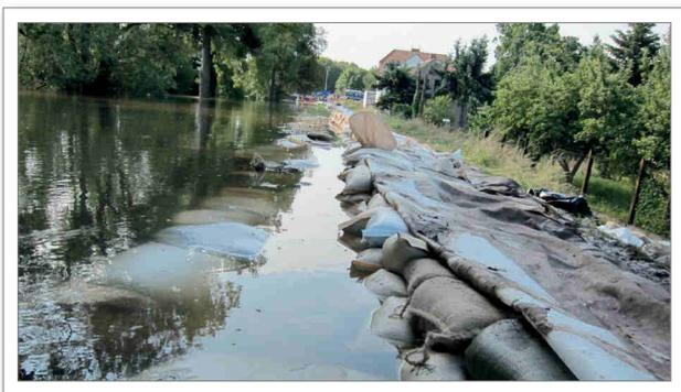
Abb. 4.16: Sicherung des linken Elbeumflutdeichs unterhalb des Gasthauses „Alte Fähre“ am 9. Juni 2013 (Foto: LHW, B. Fiedler)
