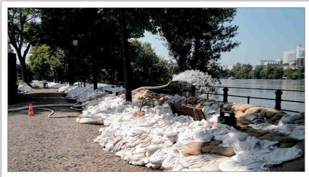
Abb. 6.18: Sandsackverbau an der Stromelbe in der Zollstraße auf dem Werder am 11. Juni 2013 nach Rückgang des Wasserstandes auf 678 Zentimeter (Foto: M. Simon)
