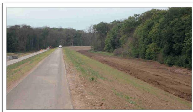
Abb. 5.8: Neuer Deich im oberen Bereich der Deichrückverlegung (Bauzustand im Juni 2014) mit wasserseitiger Pflegerberme (im Bau) und luftseitigem Deichverteidigungsweg (Foto: M. Simon)
