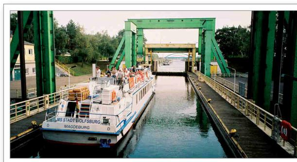
Abb. 2.10: Fahrgastschiff im Schiffstrog des historischen Schiffshebewerks Rothensee (Foto: M. Simon)
