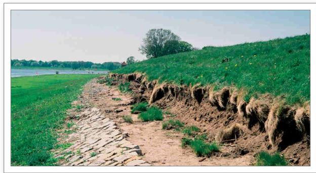
Abb. 9.6: Deichschäden infolge des Eisganges beim Hochwasser im Januar 2003 am rechtsseitigen Elbedeich oberhalb von Müggendorf (Elbe-Kilometer 463,7) Foto: M. Simon
