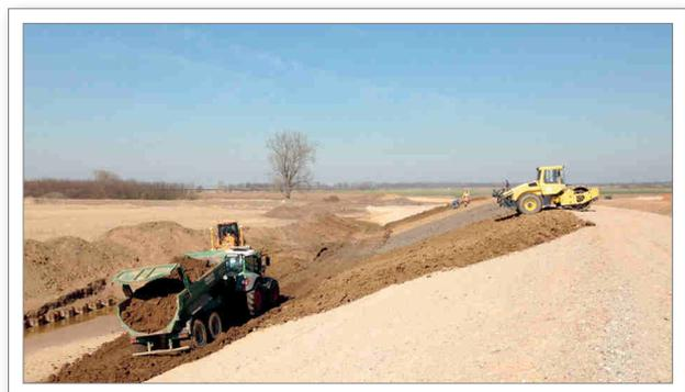
Abb. 6.28: Aufbringen der mineralischen Dichtungsschicht auf den neuen Deichabschnitt westlich von Fischbeck (Elbe-Kilometer 389,0) – Foto: LHW, R. Kürschner
