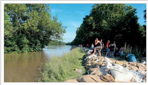
Abb. 6.21: Sicherung des linken Deichs am Elbeumflutkanal bei Pechau am 7. Juni 2013, zwei Tage vor dem Hochwasserscheitel (Foto: LHW, B. Fiedler)
