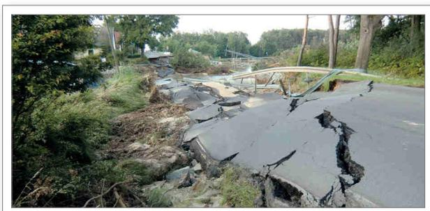
Abb. 6.24: Zerstörte Straße Hohenwarthe-Niegripp vor der Schleuse Niegripp nach dem Deichbruch (Foto: LHW, R. Kürschner)
