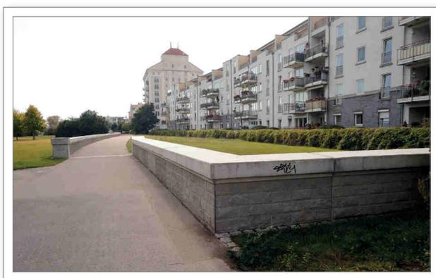
Abb. 4.15: Hochwasserschutzmauer entlang der Straße „An der Elbe“. Rechtwinklig ist der Abzweig der Mauer entlang der Böschung der Klinke (Foto: M. Simon)
