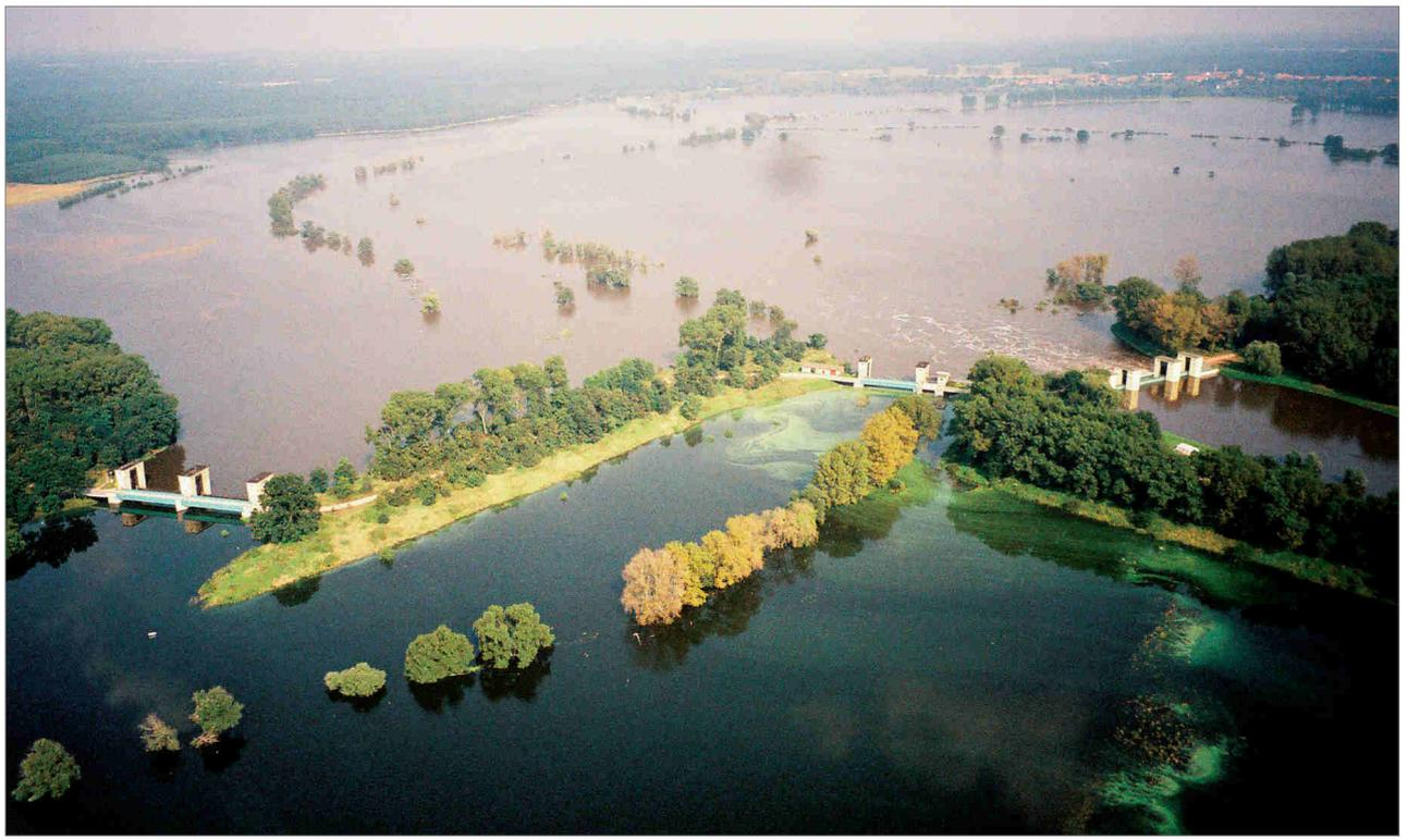
Abb. 5.11: Wehrgruppe Quitzöbel bei Havelberg beim Hochwasser im August 2002 mit geöffnetem Einlasswehr Neuerben (rechts) zur Flutung der Havelniederung sowie dem Altarmwehr (Mitte) und dem Durchstichwehr (links) – Foto: M. Simon
