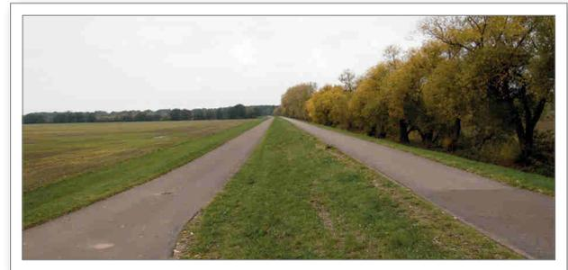
Abb. 6.12: Sanierter rechter Saaledeich im Bereich der ehemaligen Bruchstelle (Foto: LHW, P. Butz)
