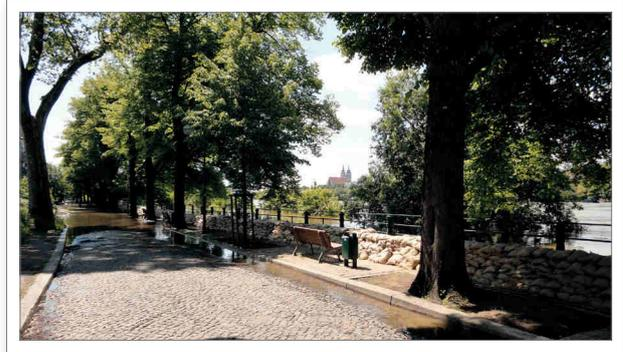
Abb. 4.11: Sandsackverbau an der Stromelbe in der Zollstraße auf dem Werder am 7. Juni 2013 bei einem Wasserstand von 714 Zentimeter am Pegel Magdeburg-Strombrücke - 33 Zentimeter unter dem Hochwasserscheitel (Foto: M. Simon)
