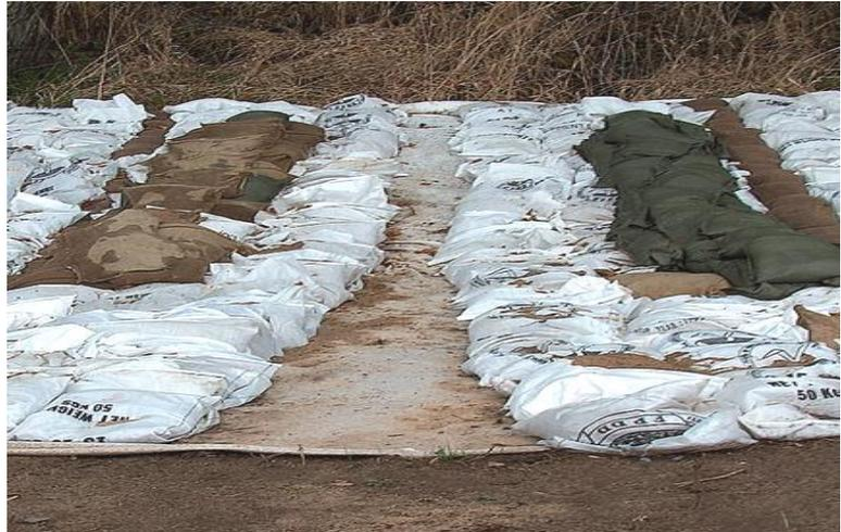
Foto 26: Auflast mit Vlies und Sandsäcken
