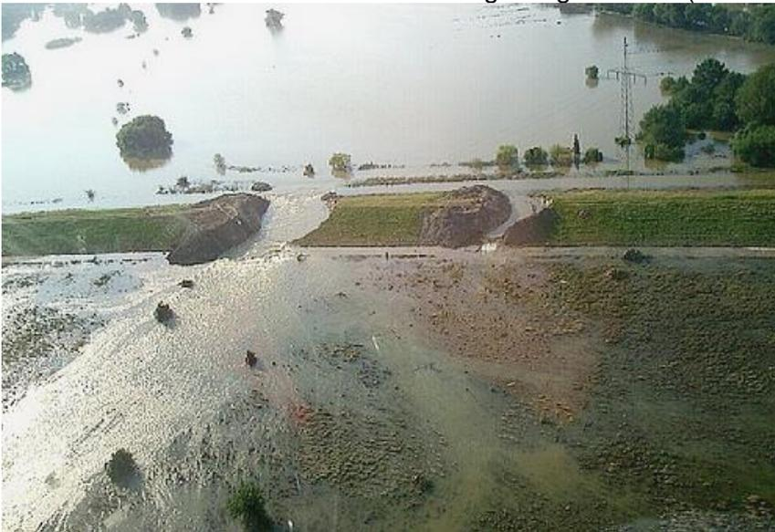
Foto:38, linker Muldedeich östlich Bitterfeld, bei Friedersdorf, Schlitzung des Deiches, damit das Wasser in der Goitzsche zur Mulde abfließen kann, August 2002
