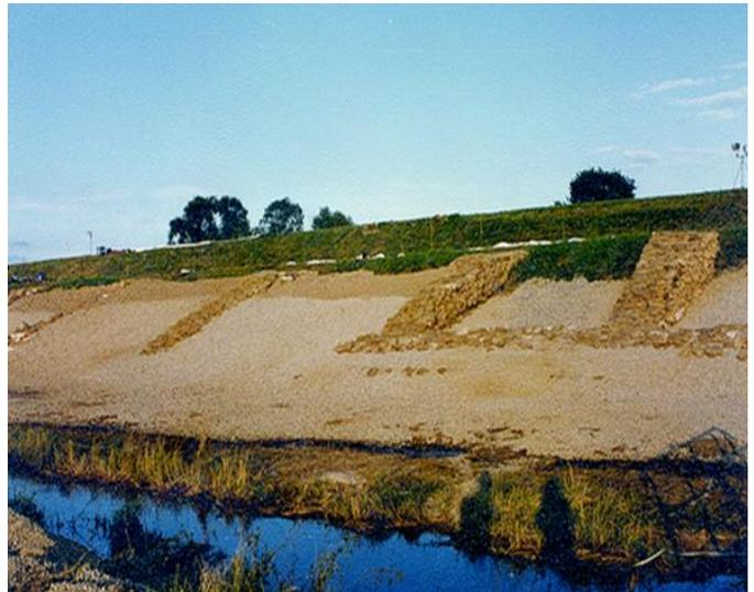
Foto 35: massive landseitige Sicherung
