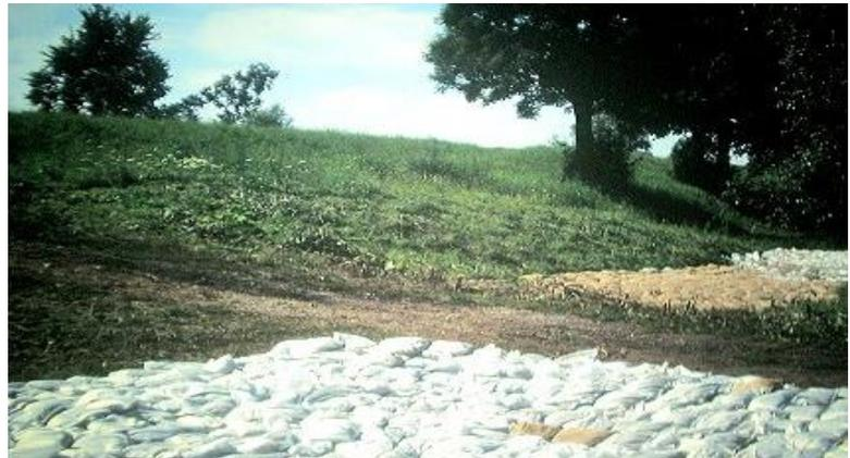
Foto 27: Auflast mit Kies in Sandsäcken
