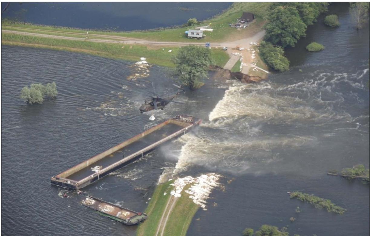
**Abbildung 4.9:** Die Luftaufnahme vom 16. Juni 2013 zeigt die Deichbruchstelle bei Fischbeck nach dem Versuch, die Bruchstelle durch das Einschwimmen und die Sprengung zweier Lastkähne zu schließen. Einen Tag später wurde ein drittes Schiff an die Bruchstelle manövriert und versenkt. (Quelle: LHW).
