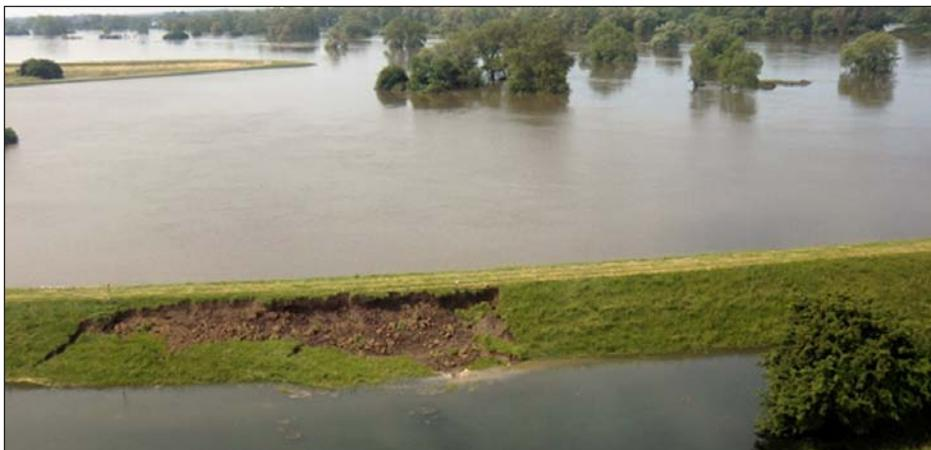
**Abbildung 4.3:** Landseitige Böschungsabrutschung an einem Elbedeich bei Hohengöhren (Quelle: LHW).
