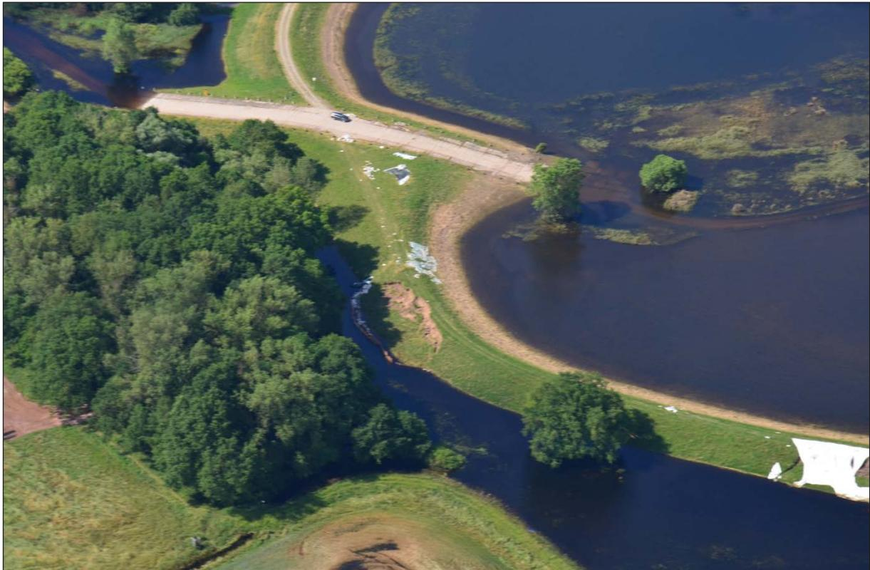
**Abbildung 4.12:** Die Luftaufnahme vom 22. Juni 2013 zeigt beide Deichabrutschungen am rechtsseitigen Elbedeich bei Hohengöhren. Die Schadstelle am rechten Bildrand ist mit Geotextil abgedeckt (Quelle: LHW).
