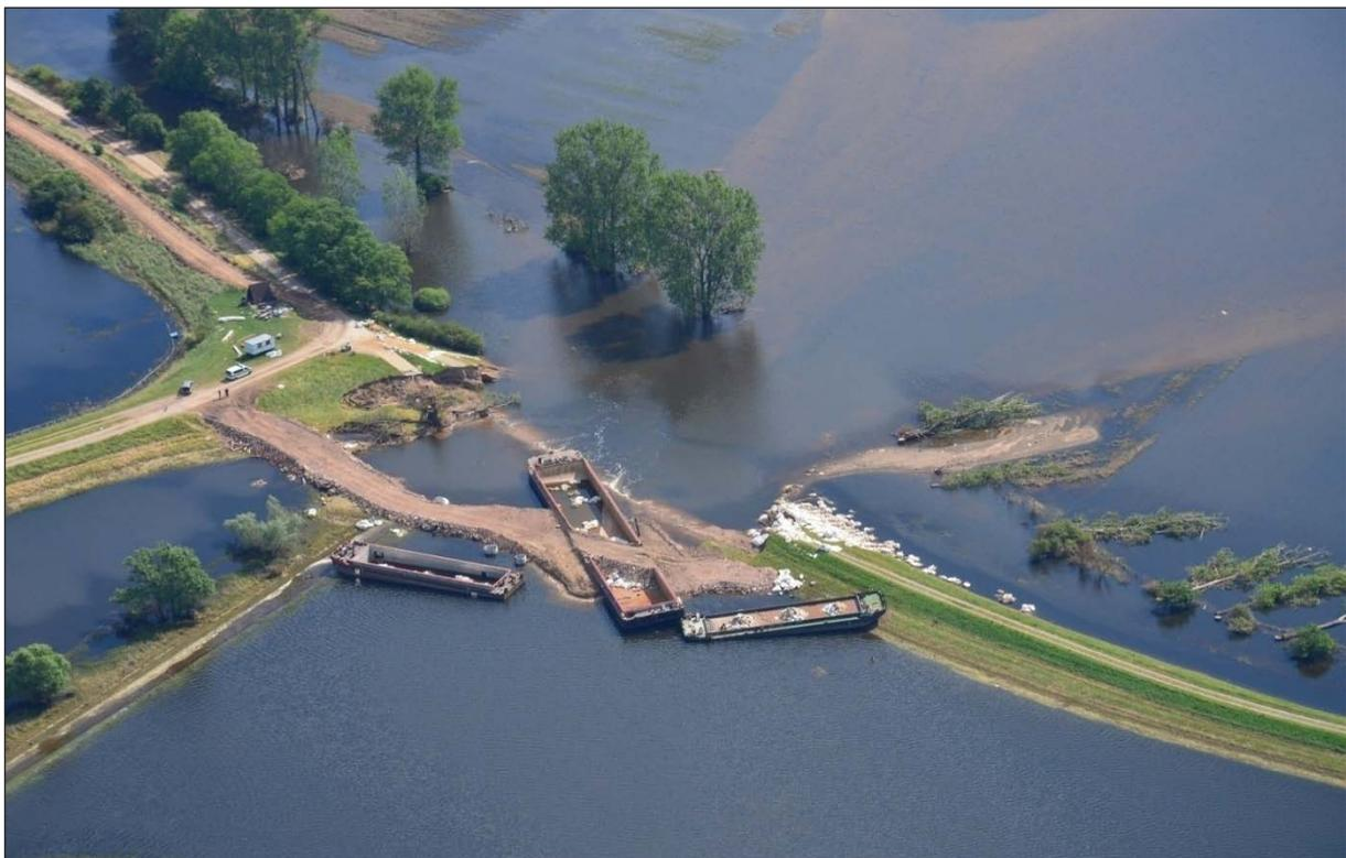
**Abbildung 4.5:** Drei kontrolliert versenkte Schiffe verschließen die Deichbruchstelle Fischbeck (Quelle: LHW).
