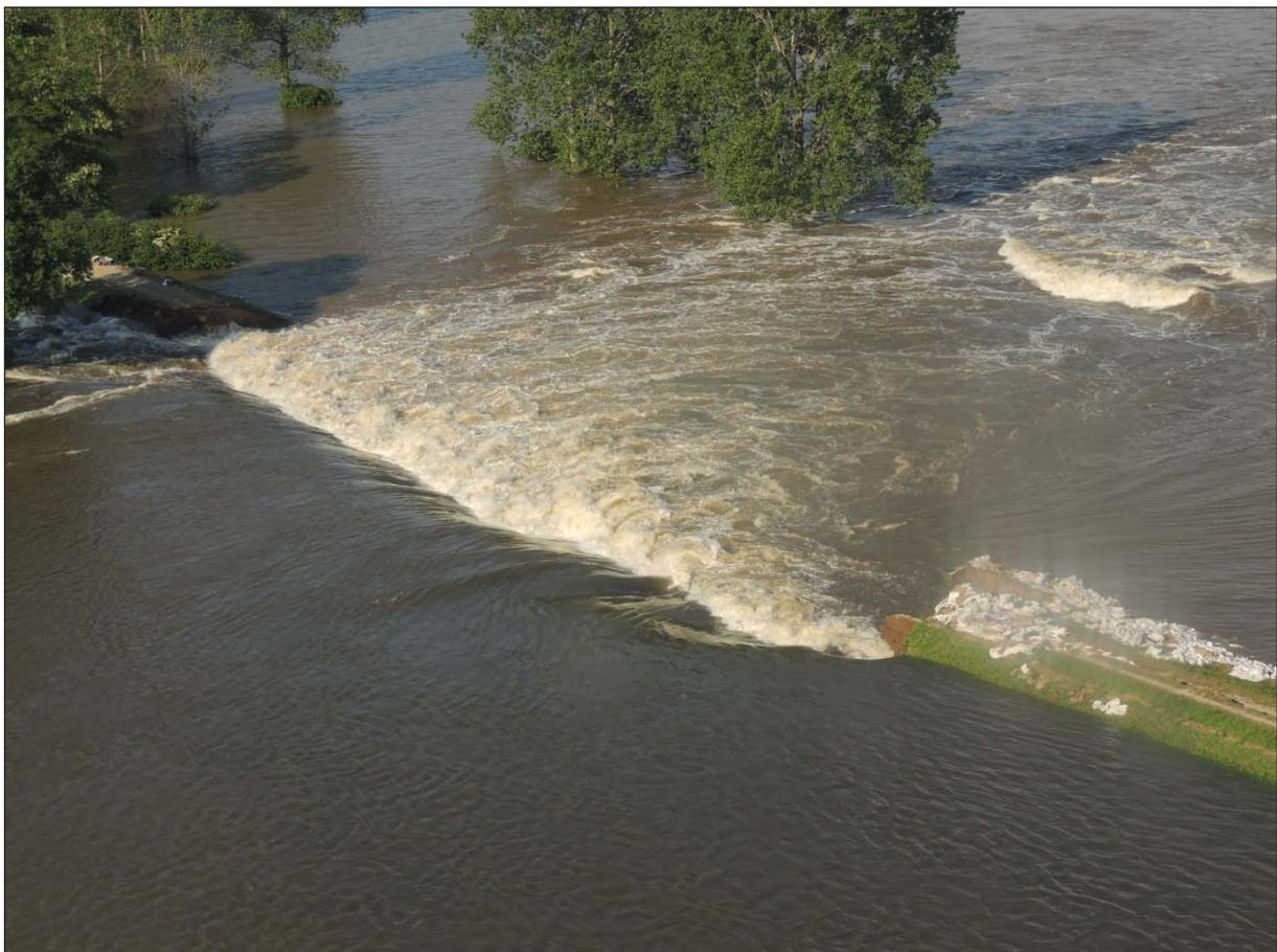
**Abbildung 4.8:** Blick auf den Deichbruch bei Fischbeck von der Wasserseite in Fließrichtung (Quelle: LHW).
