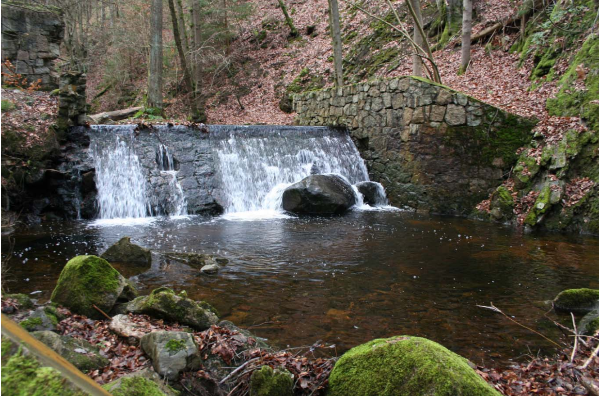
Wasserkraftanlage Bereich Steinerne Renne/ Holtemme (31.01.2020)
