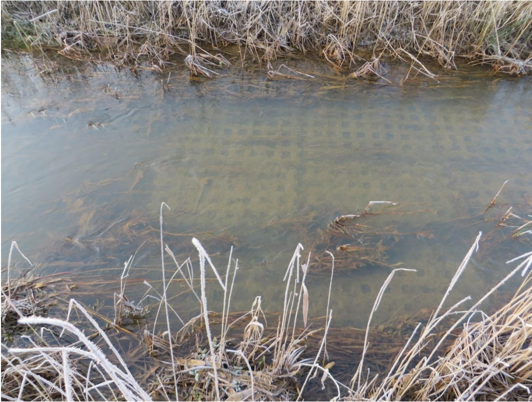
Abb.1: Rasengitter-Betonplatten in der Gewässersohle (15.02.2015)
