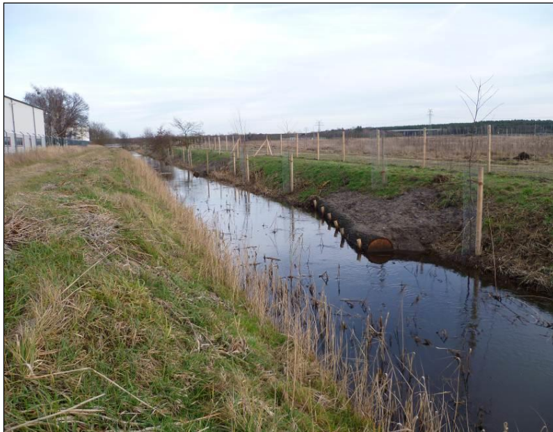
Abb. 22: im Ufer eingrabener Totholzstamm im Lausebach bei Gardelegen (Foto: Wernike)
