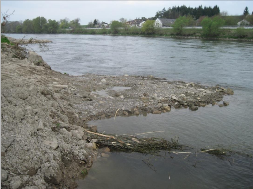
Abb. 23: Steinbühne als Uferstruktur (Quelle: LfU Bayern)
