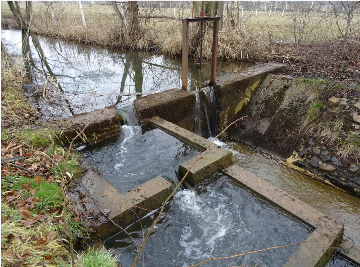
Abb. 4: Stauanlage mit Fischaufstiegsanlage [Quelle: BCE Begehung 28.03.2018]
