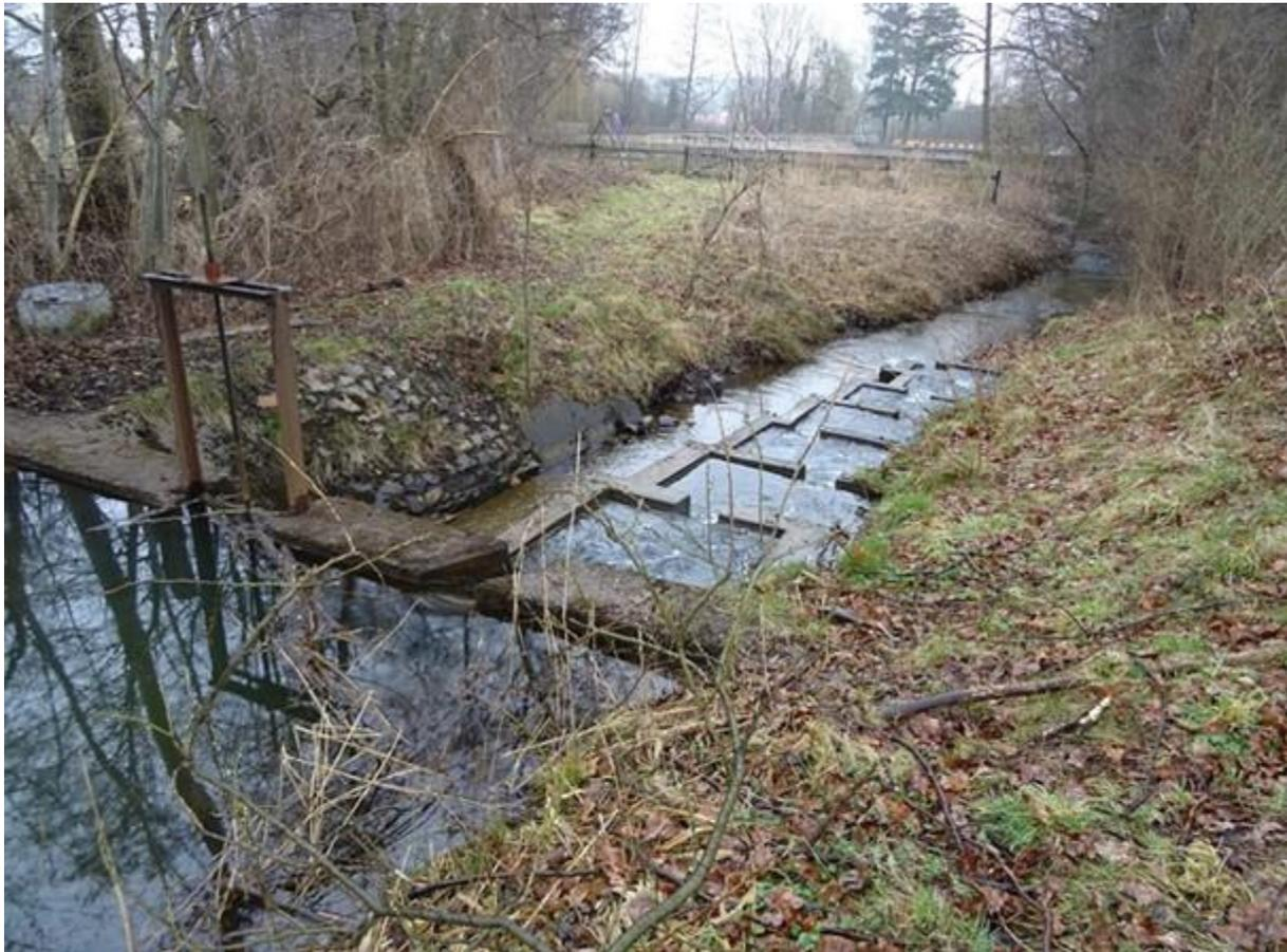
Abb. 3: Stauanlage mit Fischaufstiegsanlage [Quelle: BCE Begehung 28.03.2018]
