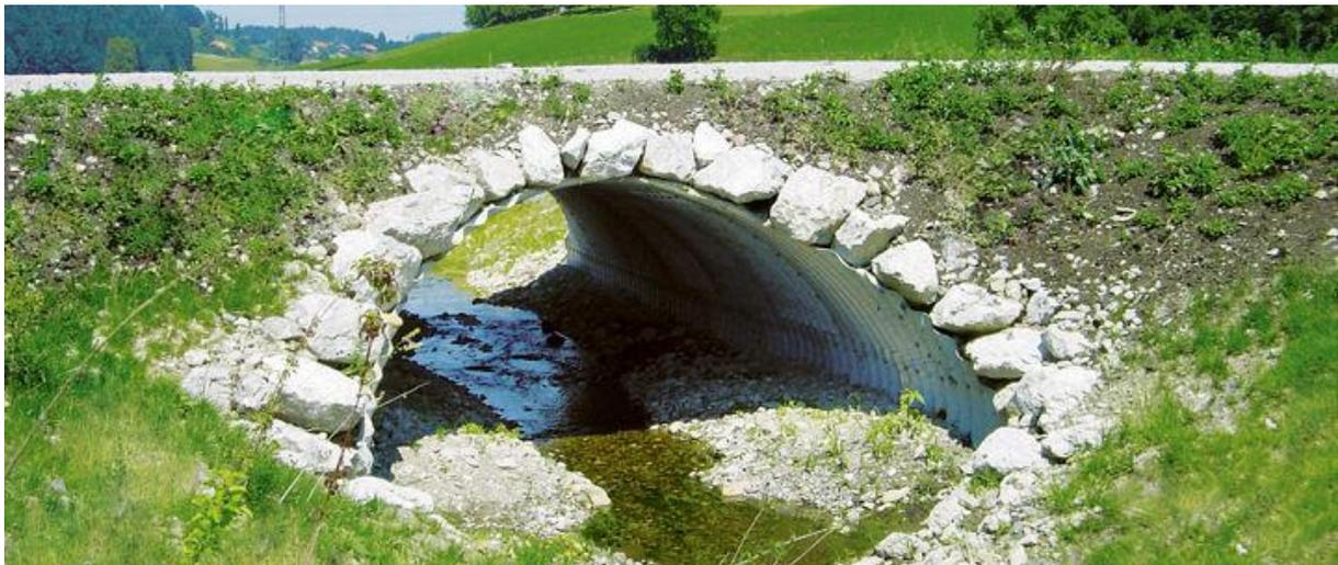
Abb. 8: Ausführungsbeispiel Maulprofilrohr. Quelle: [www.sytec.ch](http://www.sytec.ch)
