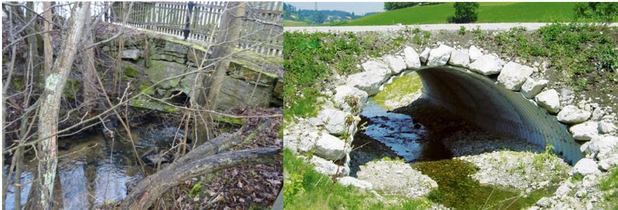
Abb. 8: RI\_WH04 - Verrohrte Überfahrt (links), Maulprofilrohr mit durchgängiger Gewässersohle (rechts), Quelle: BCE
