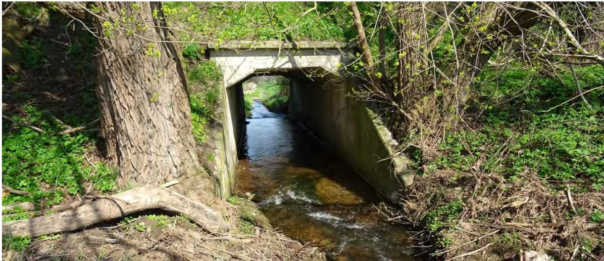
**Abb. 25:** "Eingeschränkt durchgängige" Eisenbahnbrücke mit glatter Betonsohle in der Schölecke (Fl.-km 3+020)
