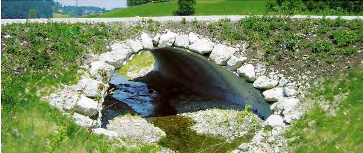
**Abb. 30: Ausführungsbeispiel Maulprofilrohr. Quelle: sytec.ch**
