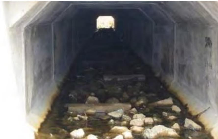
**Abb. 29: Sohlgestaltung im Durchlass mit Geröll und Kies. Quelle: H. Diel (GFG GmbH)**
