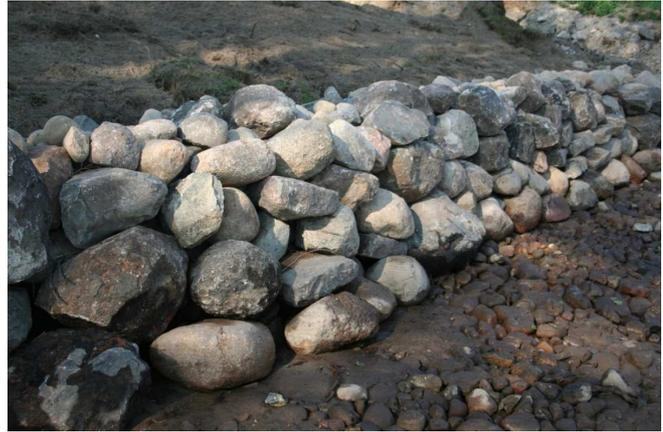
Abbildung 6: Kluftmauerwerk aus Quadersteinen und Feldsteinen
