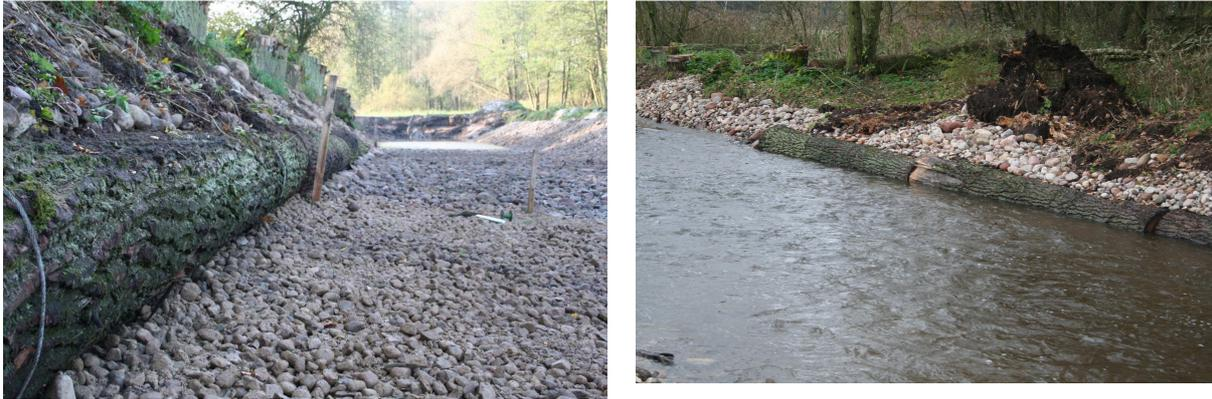
Abbildung 8: unterströmte Totholzstämmen am Böschungsfuß
