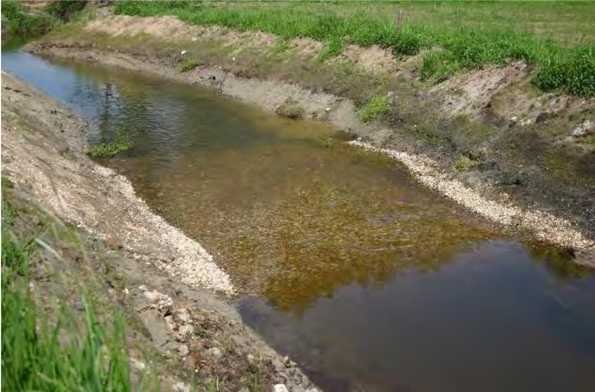
Foto 21: Kiesriffle (Bauzustand)
