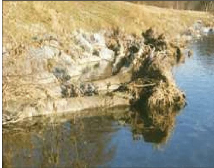
*Abb. 49: Stämme mit Wurzelstock im Ufer eingegraben, Quelle: [24]*
