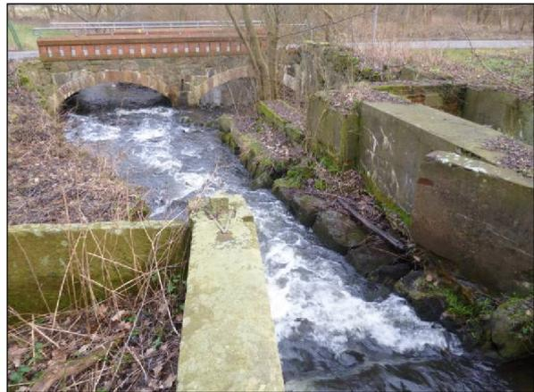
Abb. 60: Ehemalige Mühlenstandorte im Harper Mühlenbach die zu Sohlgleiten umgebaut wurden: Dietrichsmühle, Station 12+741(links) und Mühle Barnebeck, Station 15+317 (rechts).
