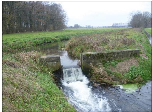
*Abb. 64: Gewässerabschnitt der Jeetze mit verringerter Wasserführung (links) und Abschlagsbauwerk in den Stolpengraben (rechts) (Foto: Wernike)*
