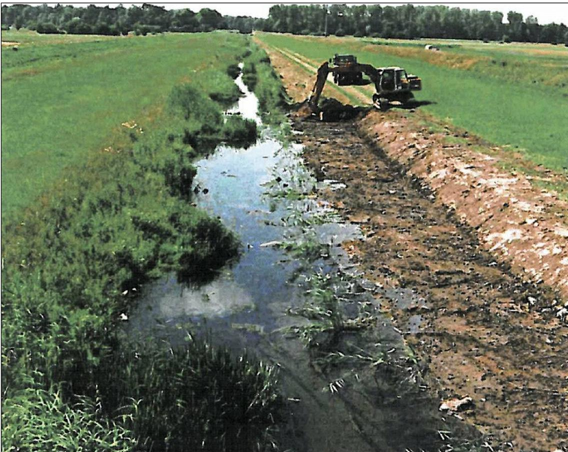
Abb. 54: Einseitige Räumung an einem Flutkanal. Der verbleibende Bewuchs strukturiert weiterhin das Bett, Quelle: [18]
