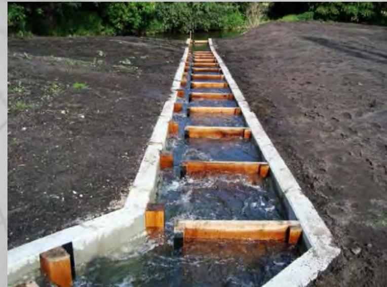
Foto: Beispiel für Technische Fischaufstiegsanlage
