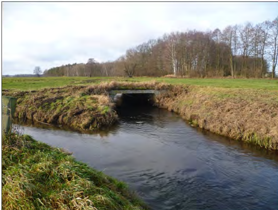
Abb.4: Brücke, Station 11+974, oberhalb der Mündung des Kalten Grabens
