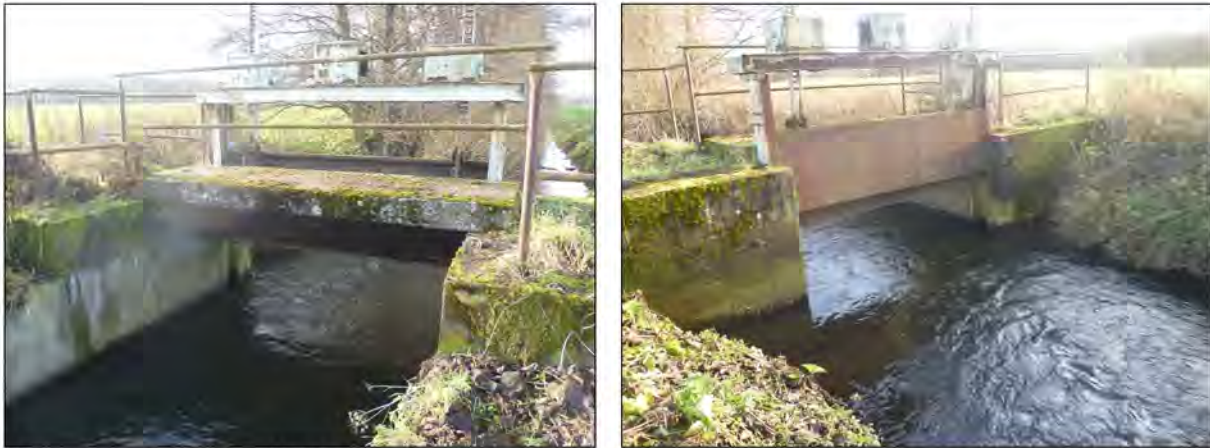
Abb. 1: Stauanlage Wistedt Unterwasser (links), Stauanlage Wistedt Oberwasser (rechts) (08.12.2011)
