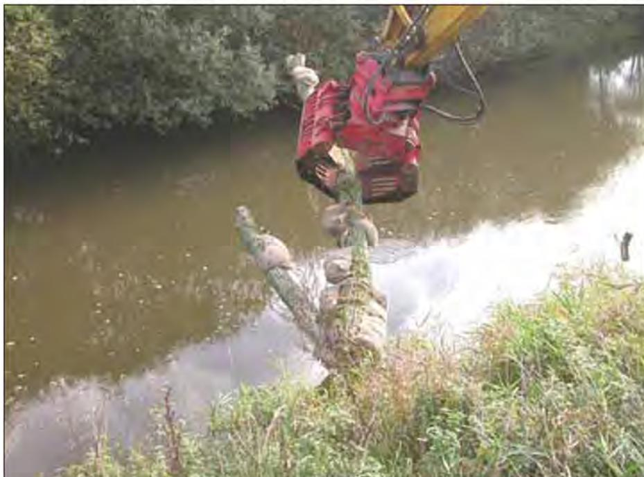
Abb. 7: Beispiel Einbau eines mit Jutesäcken beschwerten Totholzelements an der Hunte [39]
