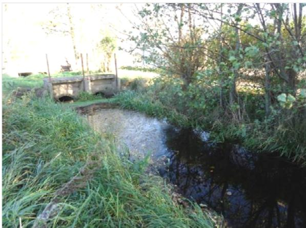
Foto 11: Durchlass mit Stau einrichtung direkt oberhalb der Wustrewer Straße – Löschwasserentnahmestelle
