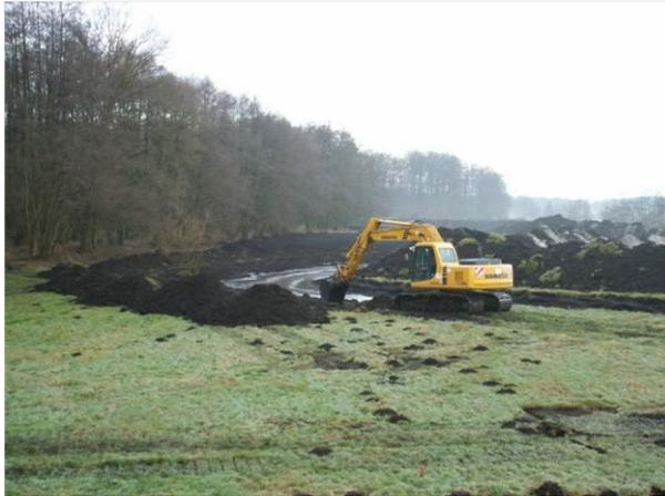
Foto 27: Neutrassierung eines Gewässerlaufes, Nebel bei Hoppenrade (M-V), im Bau
