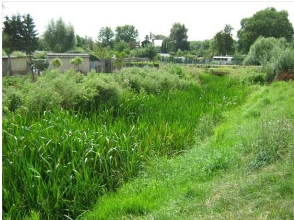
Foto 31: gerader Gewässerlauf, der aufgrund von fehlender Beschattung und Stauhaltung völlig verkrautet ist, Ausgangssituation der Warbel
