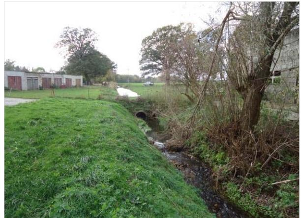
Foto 16: Durchlass mit Stauvorrichtung oberhalb der alten Mühle – **Löschwasserentnahmestelle**
