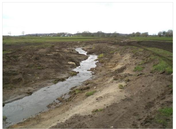
Foto 30: Gewässerabschnitt „nach“ erfolgter Neuprofilierung
