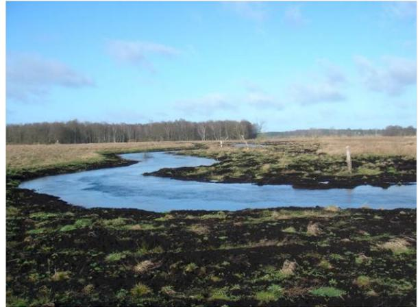
Foto 28: Neutrassierung eines Gewässerlaufes, Nebel bei Hoppenrade, 1 Jahr nach Fertigstellung
