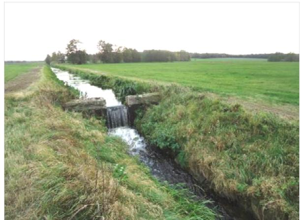
Foto 3: im Gewässerlauf vielfach eingesetzte Kombination aus Doppeldurchlass mit Stau-einrichtung
