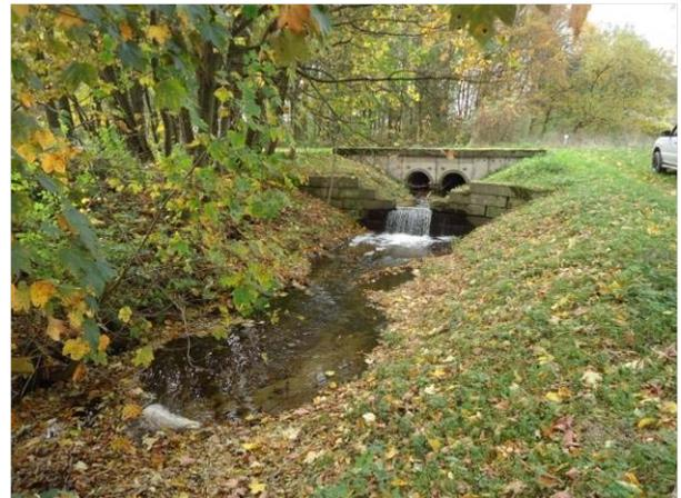
Foto 22: ... direkt unterhalb einer Bauwerkskombination aus Absturz und Doppeldurchlass
