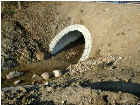
Foto 34: unter einem ländlichen Weg eingebauter Durchlass aus Wellblechstahl, im Durchlass befindet sich durchgängig Sohlsubstrat von 30 bis 40 cm Stärke, Haubach östlich von Rostock (M-V)
