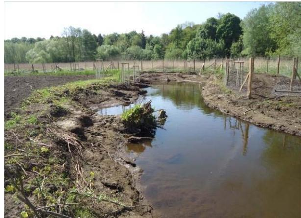
Foto 32: nach erfolgter Laufverschwenkung und Gefälleanpassung wurde die Bepflanzung auf der Nordseite in kleinen Gruppen, die Bepflanzung auf der Südseite als aufgelockerter Streifen bis in den Gewässernahbereich hinein geführt; Warbel und Nahbereich unmittelbar nach Fertigstellung der Bepflanzung
