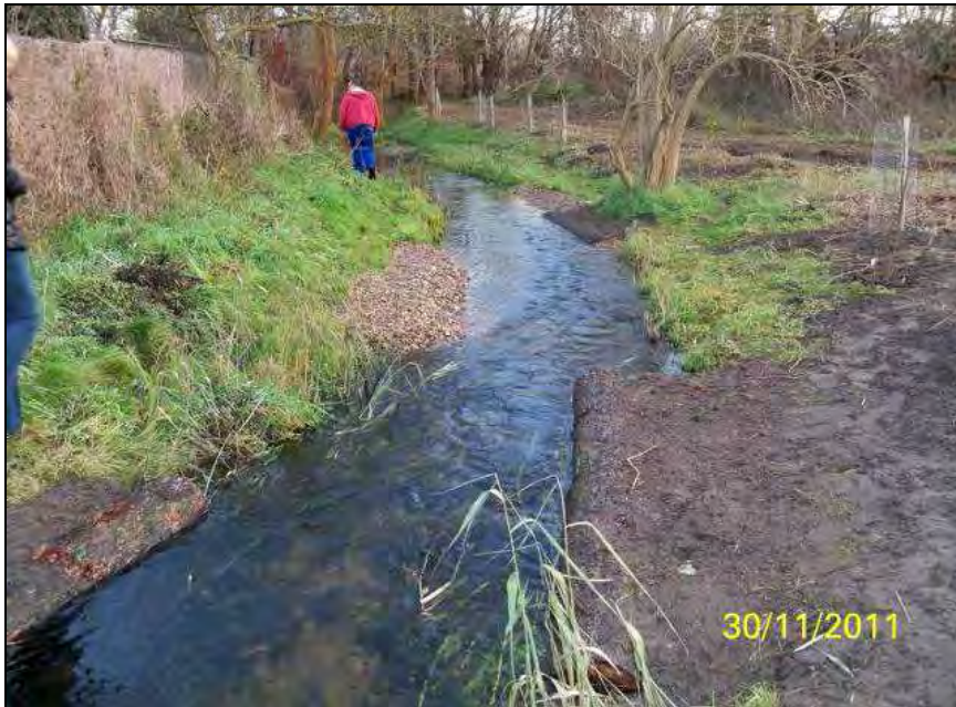
Abbildung 7: Querschnittseinengung durch Kombination Totholz und Kiesschüttung
