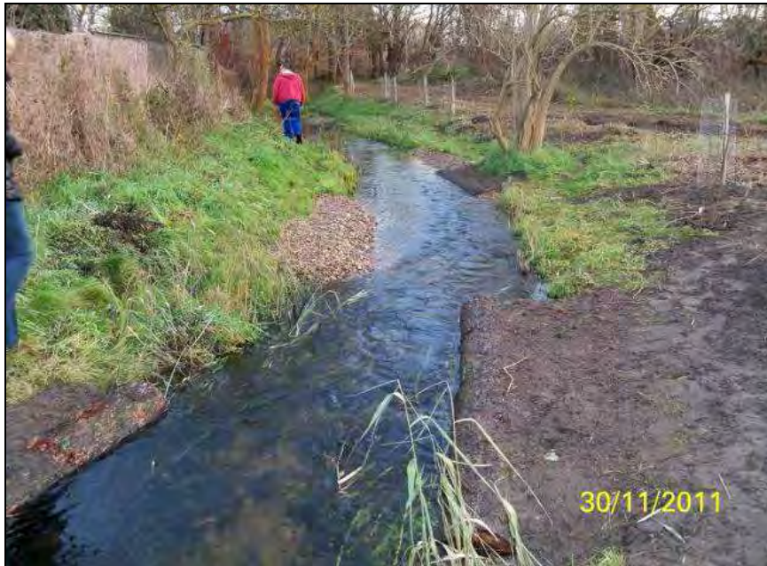
Abbildung 6: Querschnittseinengung durch Kombination Totholz und Kiesschüttung
