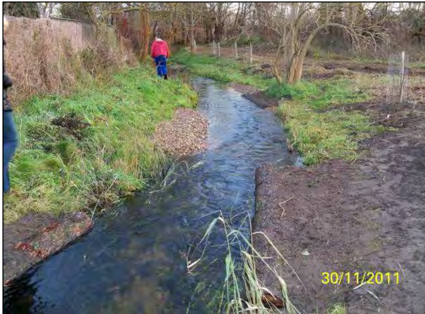
Abbildung 7: Querschnittseinengung durch Kombination Totholz und Kiesschüttung
