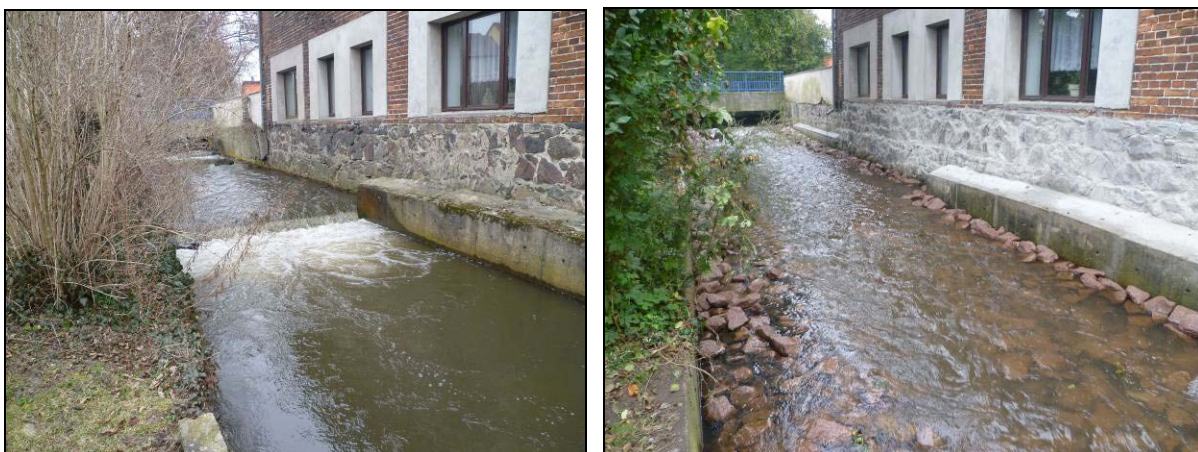
Abbildung 60: Ehemaliger Mühlenstandort in der Lindauer Nuthe im Stadtgebiet Zerbst bei Station 17+030 vor dem Umbau (links) und nach dem Umbau in eine Sohlgleite im Herbst 2013 (rechts)
