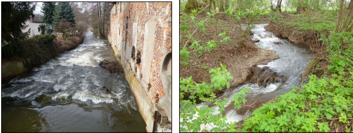
Abbildung 59: Ehemaliger Mühlenstandort an der Hauptnuthe (Poleymühle) nach Umbau in eine Sohlgleite (links) und Umgehungsgerinne des Landwehrgrabens an der ehemaligen Mühle Trebnitz (rechts).
