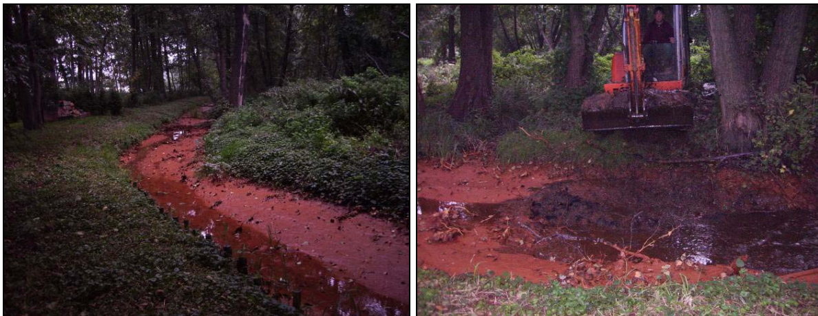
Abbildung 42: Eisenockerablagerungen im Meliorationsgraben Nord vor der Einmündung in die Boner Nuthe (links) und Entnahme des Eisenockers im Rahmen der Gewässerunterhaltung (rechts), Fotos: Bernstein
