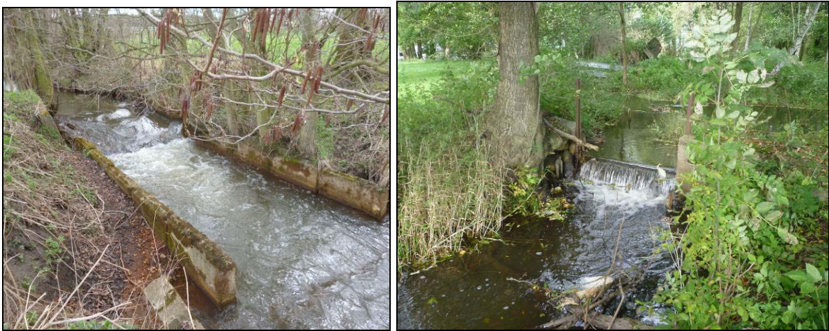
Abbildung 63: Ehemaliger Mühlenstandort „Neue Mühle“ in der Grimmer Nuthe bei Station 1+790 (links) und Mühlenstandort „Zollmühle“ bei Station 4+020 (rechts)
