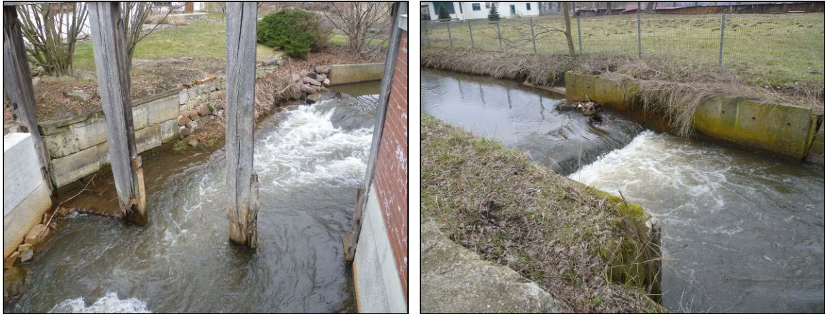
Abbildung 61: Ehemaliger Mühlenstandort in der Lindauer Nuthe im Stadtgebiet Zerbst bei Station 17+910, Ankuhnsche Mühle (links) sowie Mühlenstandort bei Station 20+310, Buschmühle (rechts) mit ökologischer Barrierewirkung
