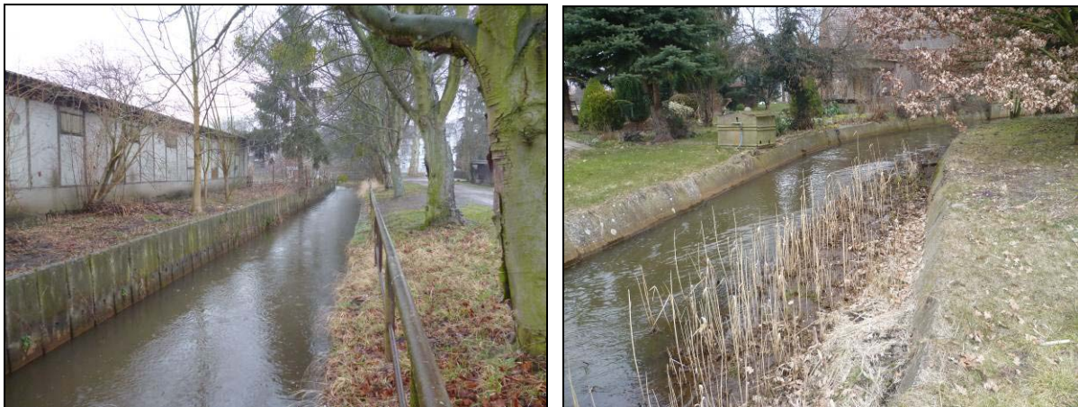
Abbildung 51: Böschungsbefestigung mit Betonplatten an der Boner Nuthe (links) und der Lindauer Nuthe (rechts) im Stadtgebiet von Zerbst (Fotos: Hofer)
