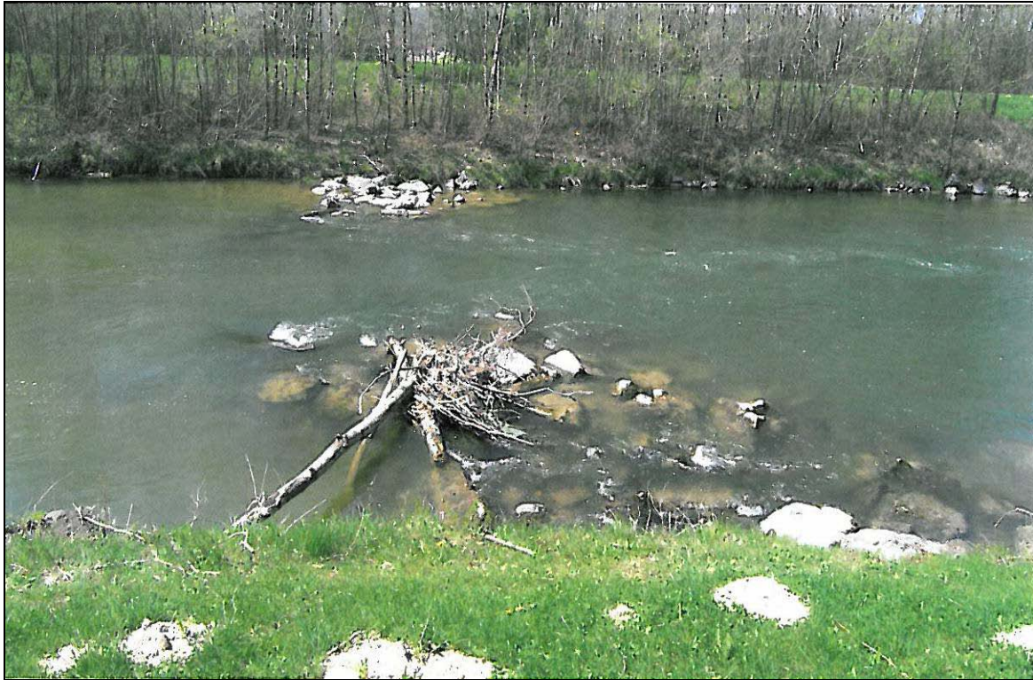
Abbildung 45: Querschnittsstrukturierung mit Steinbühne, Quelle: Gebler 2005
