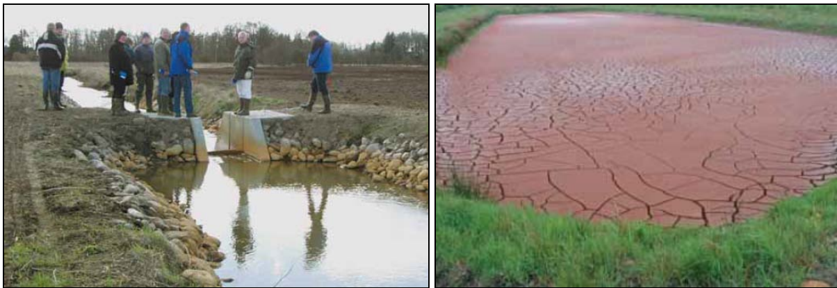
Abbildung 53: Ockerbeet im Hauptschluss eines Fließgewässers (links) und zur Ausbaggung trockengelegtes Ockerbeet (rechts), (Fotos: Madson & Tent 2000)
