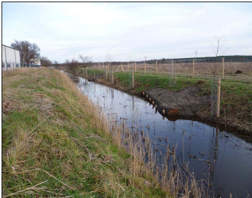
Abbildung 44: Im Ufer eingegrabener Totholzstamm im Lausebach bei Gardelegen, Foto: Wernike
