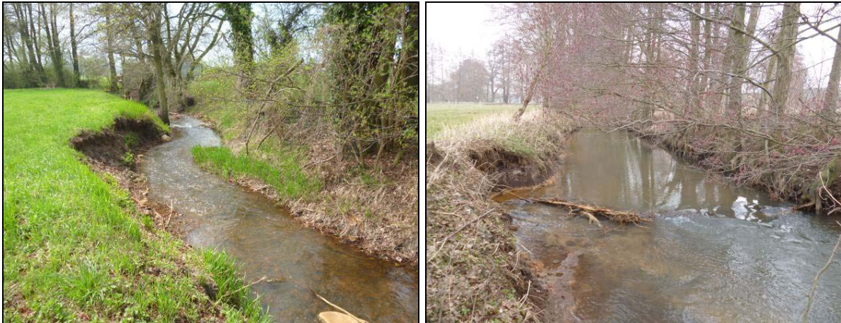
Abbildung 48: Lietzoer Nuthe nördlich von Lindau mit linksseitigem Prallhang (links) und Lindauer Nuthe nordwestlich von Kuhberge mit rechtsseitigem Uferabbruch (rechts), Fotos: Wernike
