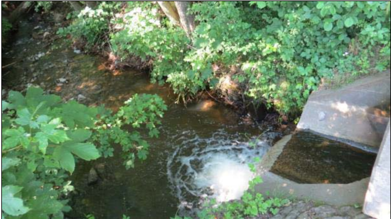
Foto 24: Absturz Osterteich, nicht durchgängig, Station km 3+590; Aufnahmedatum: 18.06.2013
