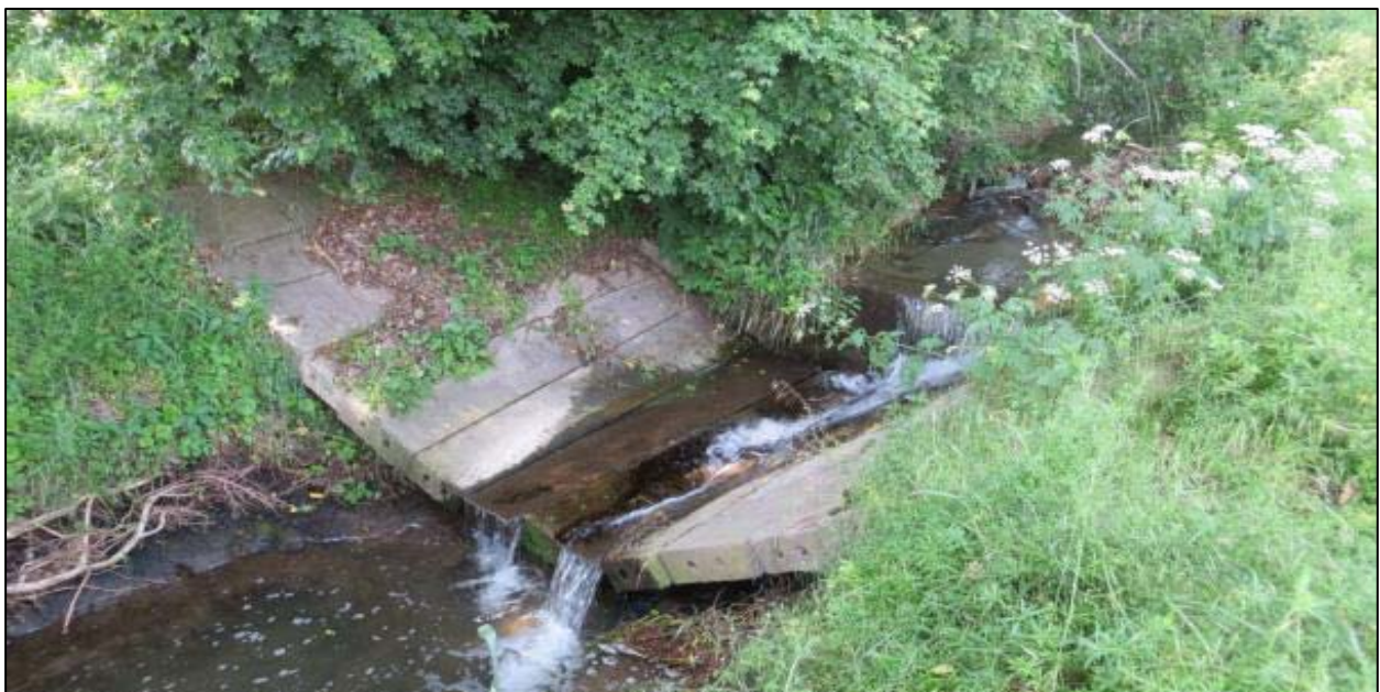
Foto 20: Absturz Bahnhofstraße, nicht durchgängig, Station km 2+450; Aufnahmedatum: 18.06.2013
