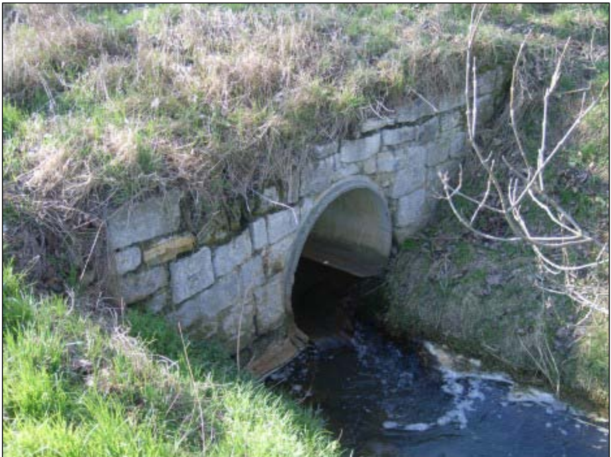
Foto 14: Verrohrung Kieswerk 1, nicht durchgängig, Station km 5+150, Aufnahmedatum: 14.07.2010
