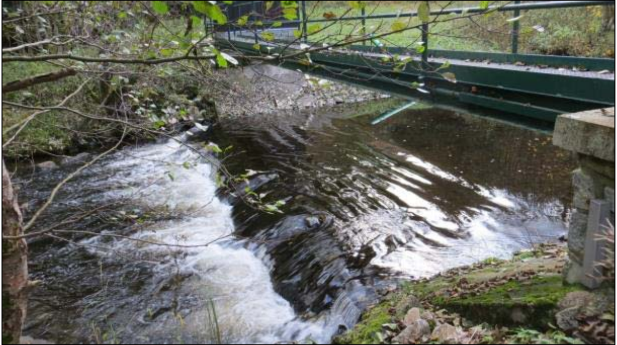
Foto 7: Pegel Königshütte, nicht durchgängig, Station km 0+540, Aufnahmedatum: 22.10.2013
