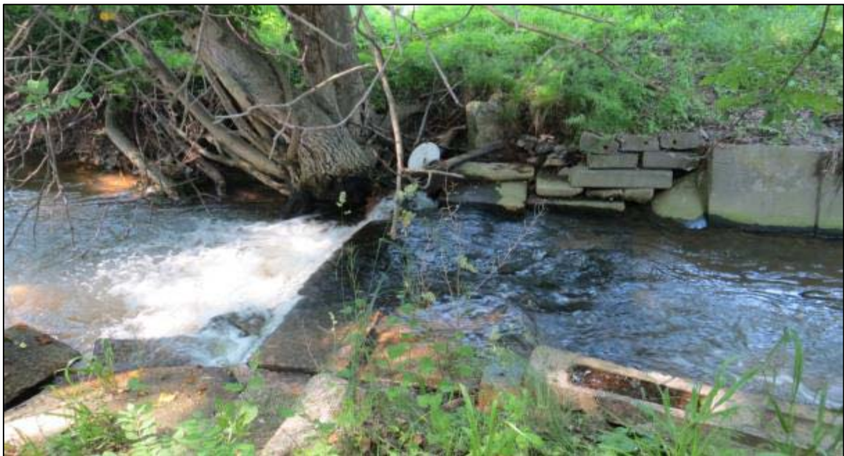
Foto 21: Absturz Am Bückeberg, nicht durchgängig, Station km 5+550, Aufnahmedatum: 18.06.2013
