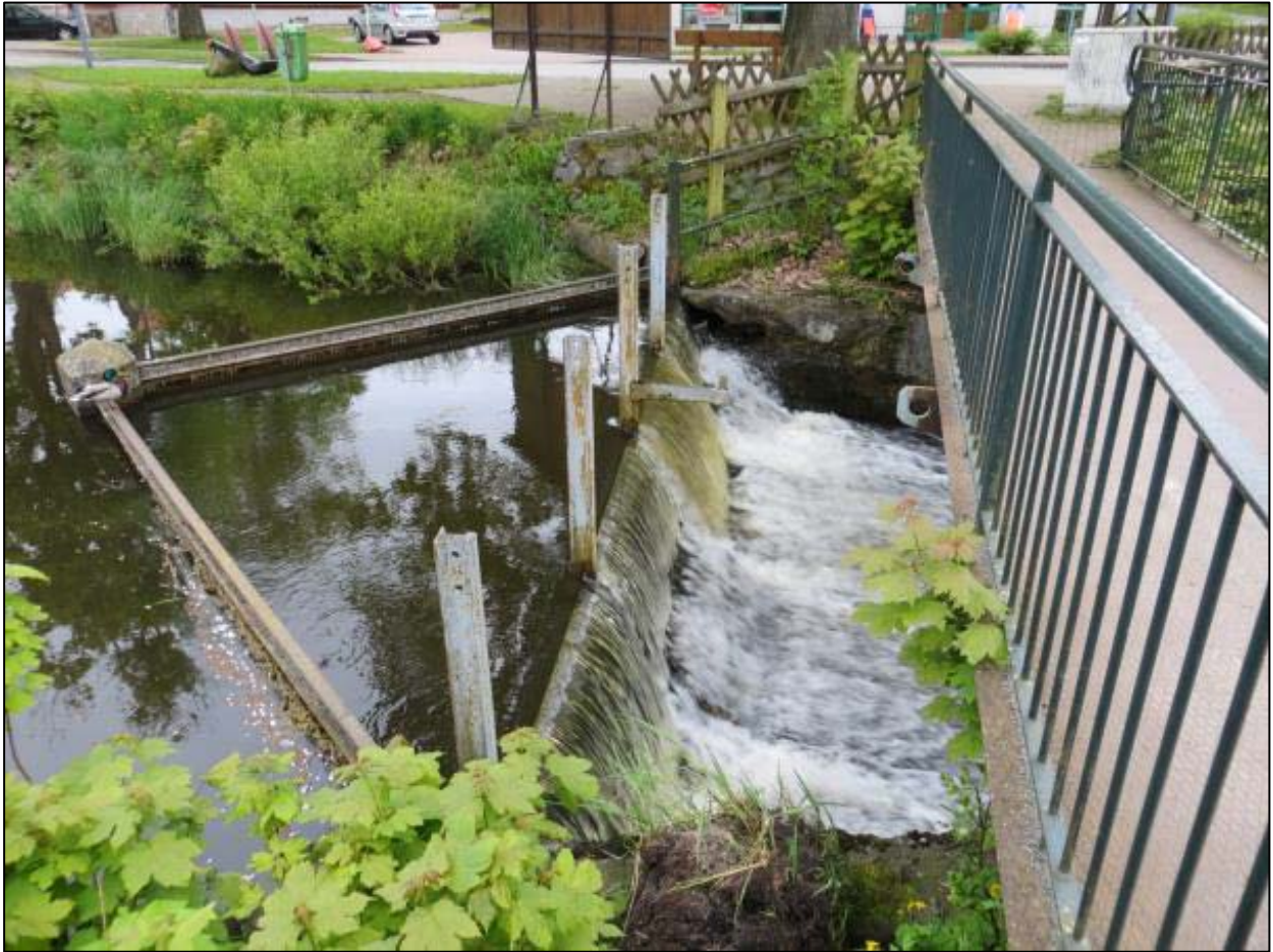
Foto 13: Absturz Hasselfall 1, nicht durchgängig, Station km 10+720, Aufnahmedatum: 30.05.2013
