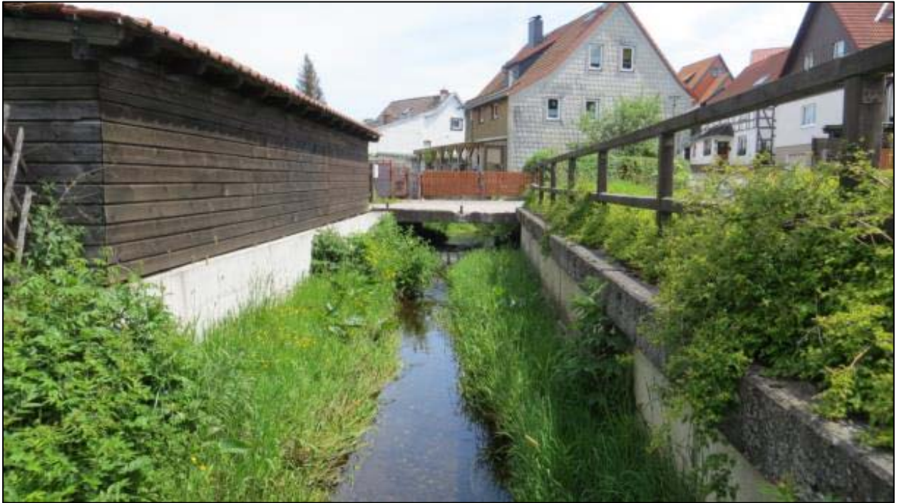
Foto 2: Stadtstrecke der Rappbode in Trautenstein, Station km 13+700, Aufnahme datum: 17.06.2013
