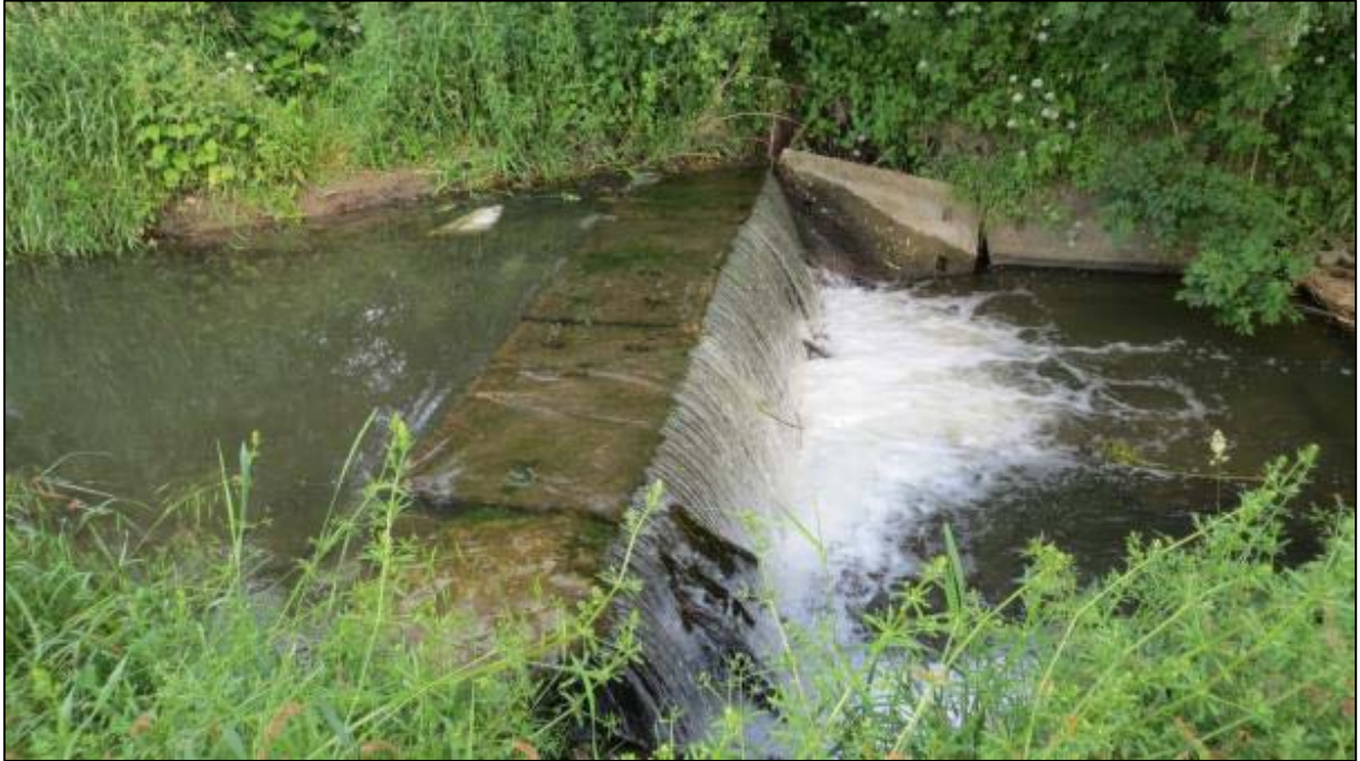
Foto 11: Absturz unterhalb der Bahnbrücke bei Wegeleben, nicht durchgängig, Station km 2+790, Aufnahme- datum: 20.06.2013
