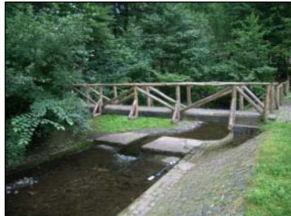
Foto 10: Pegel Treseburg bei normalen Wasserstand, nicht durchgängig, Station km 0+440, Aufnahme datum: 02.08.2009
