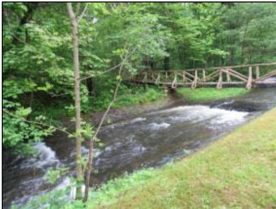
Foto 9: Pegel Treseburg bei einem erhöhten Wasserstand, bedingt durchgängig, Station km 0+440, Aufnahme datum: 30.05.2013
