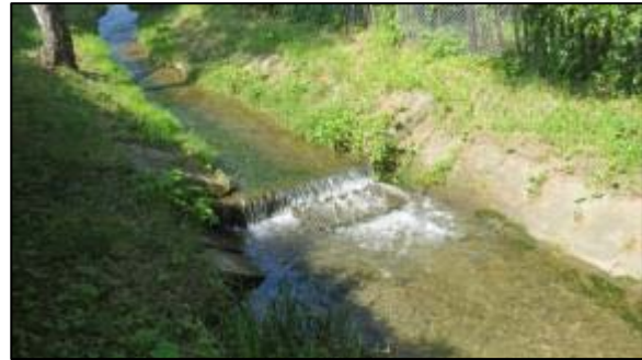
Foto 18: Absturz Harzstraße 2, nicht durchgängig, Station km 5+895; Aufnahmedatum: 18.06.2013
