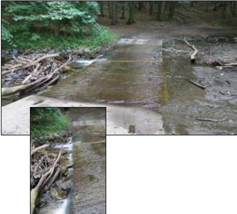
Foto 23: Furt mit Absturz Nackenberg 1, links Furt, rechts Absturz, nicht durchgängig, Station km 2+140, Aufnahmedatum: 20.06.2013
