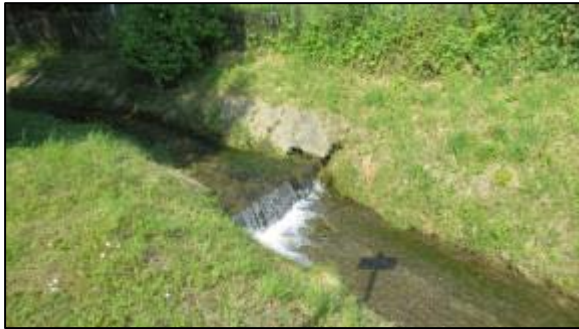
Foto 17: Absturz Harzstraße 1, nicht durchgängig, Station km 5+880; Aufnahmedatum: 18.06.2013
