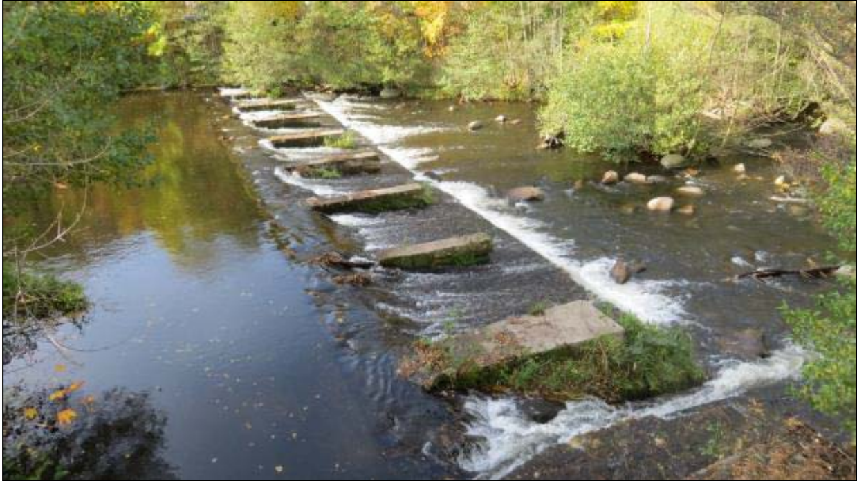
Foto 5: Wehranlage EHW II, nicht durchgängig, Station km 106+297; Aufnahmedatum: 23.10.2013
