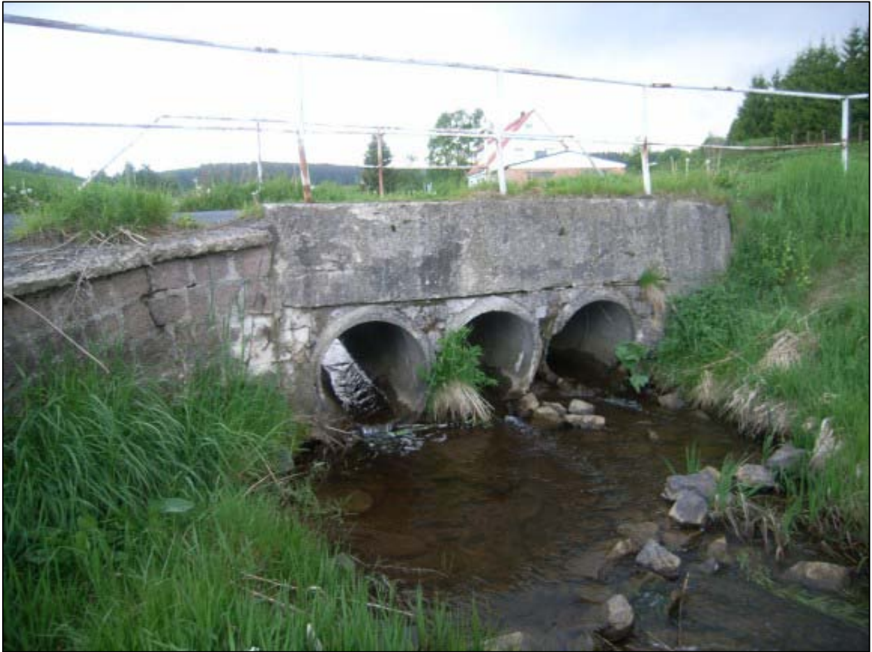
Foto 8: Verrohrung bei Benneckenstein (Harz), Bezeichnung: RB243_BW07, nicht durchgängig, Station km 23+310, Aufnahmedatum: 17.06.2013
