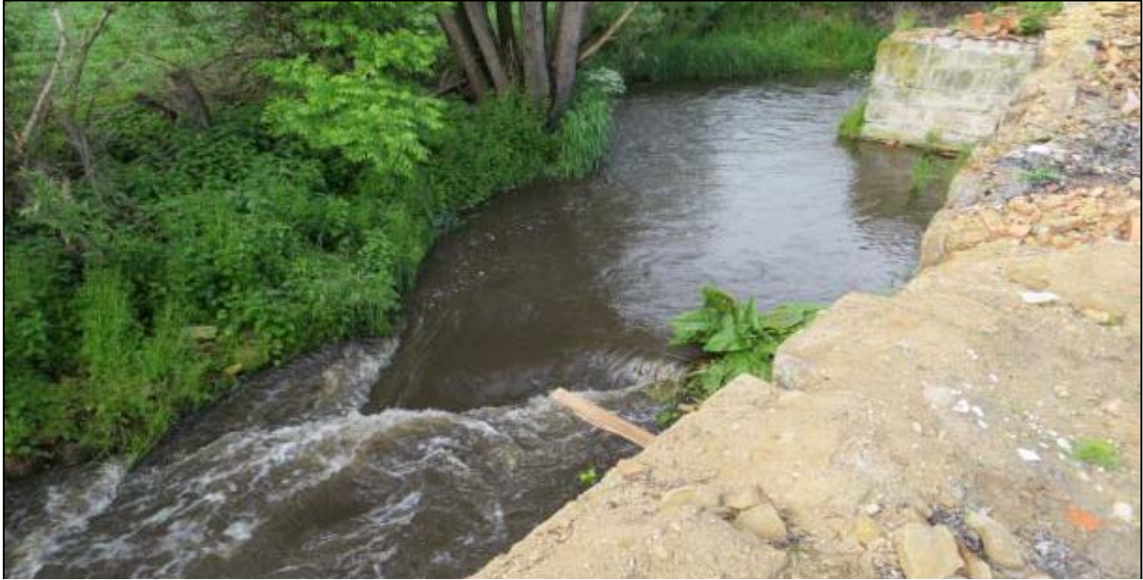
Foto 22: Absturz Obere Bruchmühle, nicht durchgängig, Station km 6+470; Aufnahmedatum: 29.05.2013
