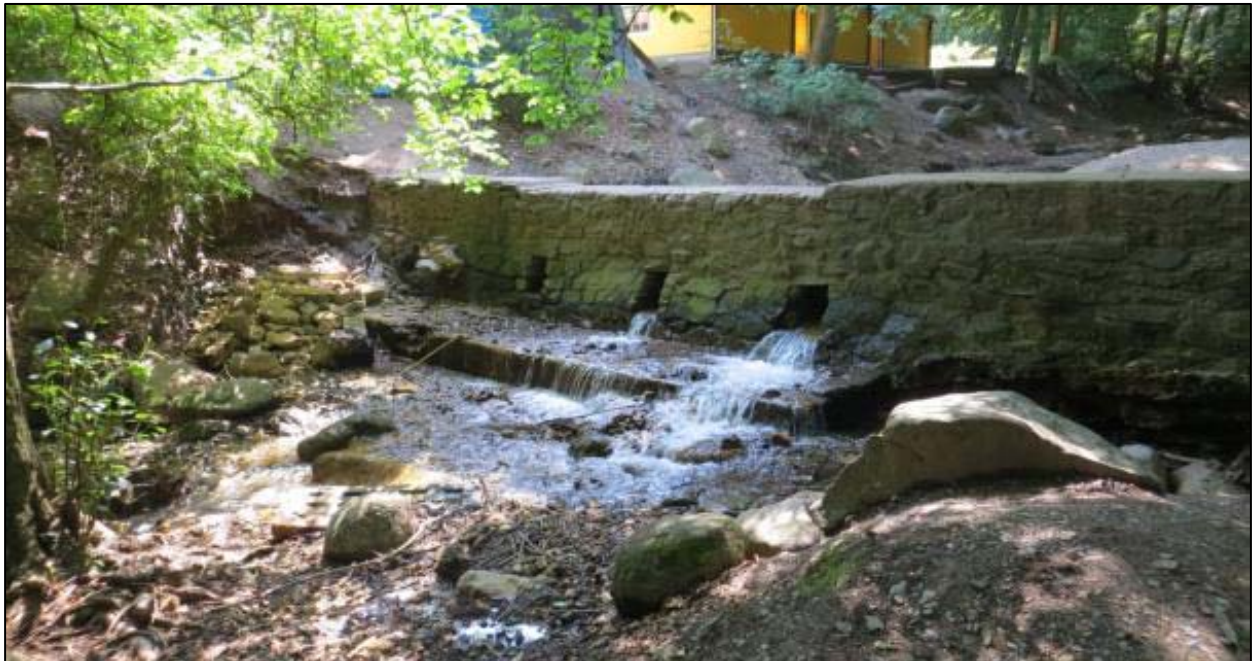
Foto 19: Geschiebesperre bei Stecklenberg, nicht durchgängig, Station km 3+480, Aufnahme vom 18.06.2013
