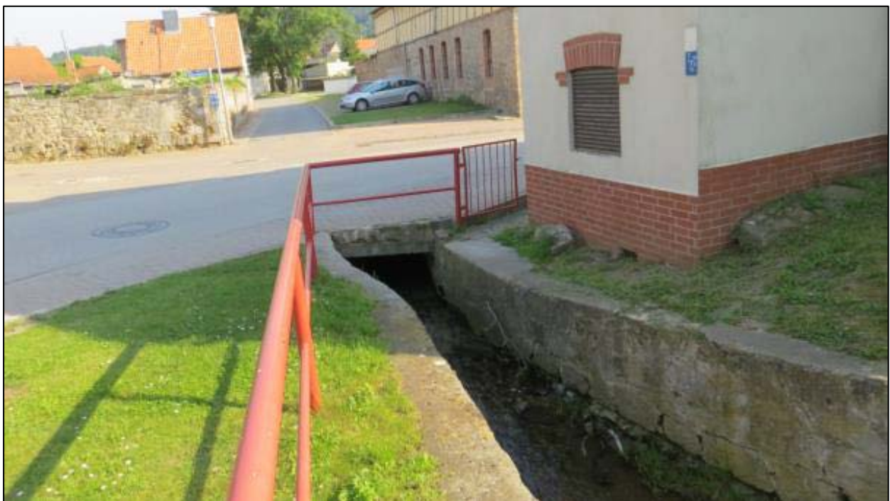
Foto 15: Verrohrung Rieder 3, durchgängig, Station km 8+170, Aufnahmedatum: 18.06.2013
