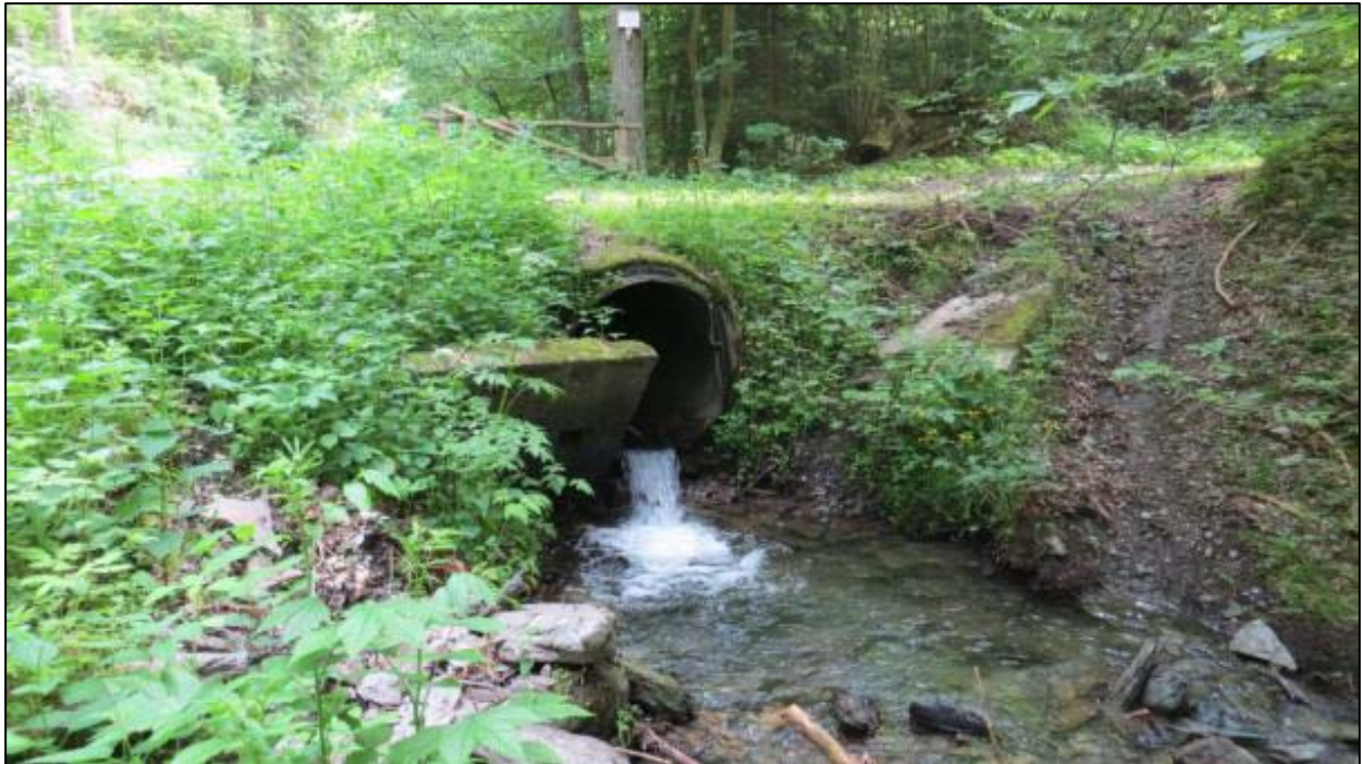
Foto 16: Durchlass 2, nicht durchgängig, Station km 0+450, Aufnahme datum: 17.06.2013
