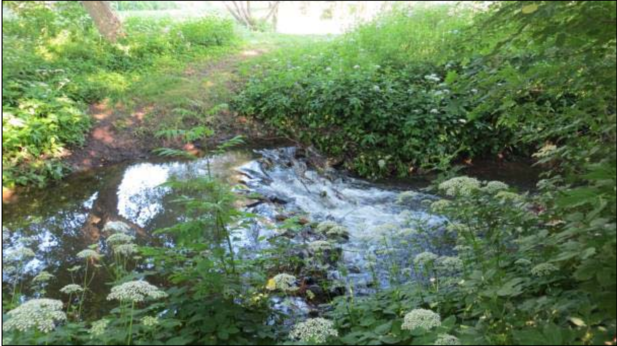
Foto 12: Absturz Quedlinburg in Höhe der Lindenstraße, Station km 5+820, Aufnahme datum: 19.06.2013
