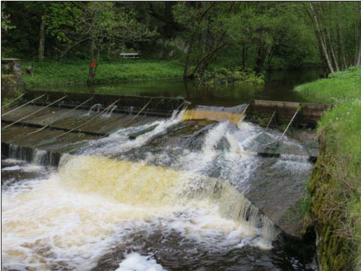
Foto 6: Stauanlage oberhalb Königshütte, Bezeichnung: KB241_BW02, nicht durchgängig, Station km 0+380, Aufnahme datum: 30.05.2013
