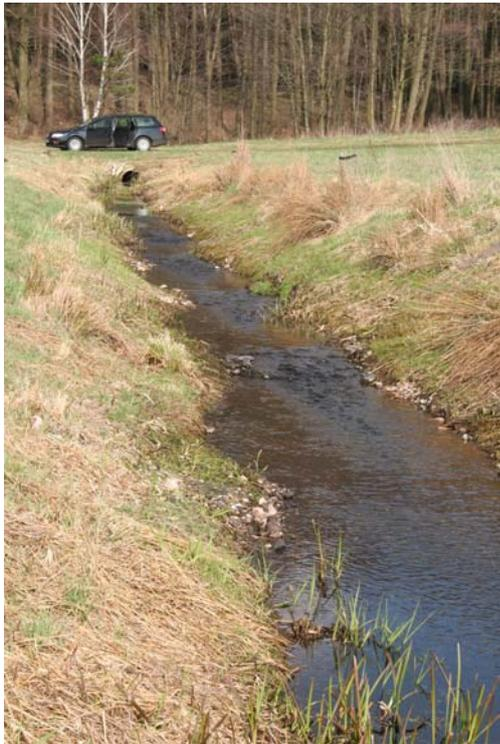
Bild 18: Sohlsicherung an einer geöffneten Verrohrung in Form einer Rausche – Kolk – Gestaltung aus Kiessubstrat
