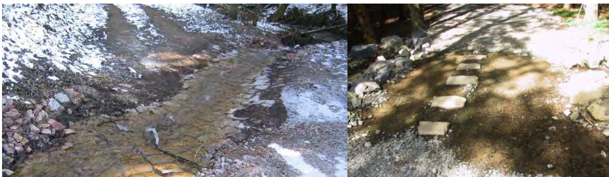
Abb. 30: Ausführungsbeispiel für Furten. Links grob verlegte Steine, rechts einzelne Trittsteine. Quellen: T. Kowalke, Gerhard Schlößer
