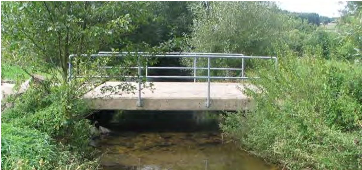
Abb. 29: Ausführungsbeispiel einer Plattenbrücke [41]
