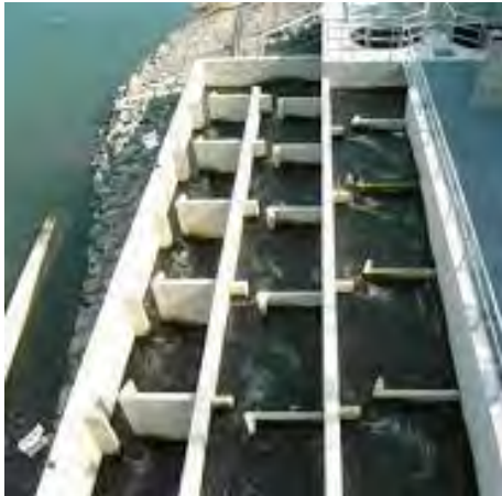
Abb. 27: Beispiel Schlitzpass als punktuelle Maßnahmenvariante [5]
