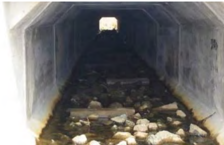
Abb. 31: Sohlgestaltung im Durchlass mit Geröll und Kies. Quelle: H.-Diel (GFG GmbH)
