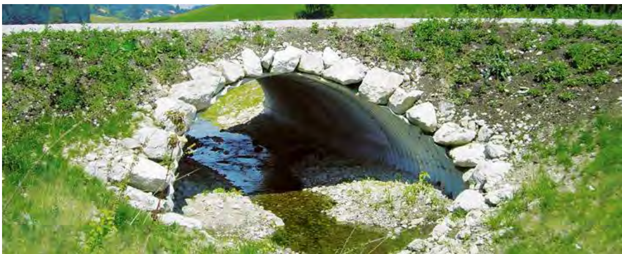
Abb. 28: Ausführungsbeispiel Maulprofilrohr. Quelle: sytec.ch
