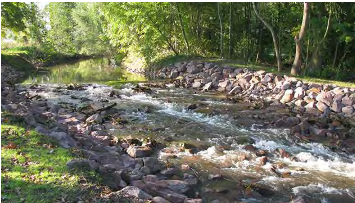
Abb. 26: Beispiel Sohlgleite mit Niedrigwasserrinne als punktuelle Maßnahmenvariante
