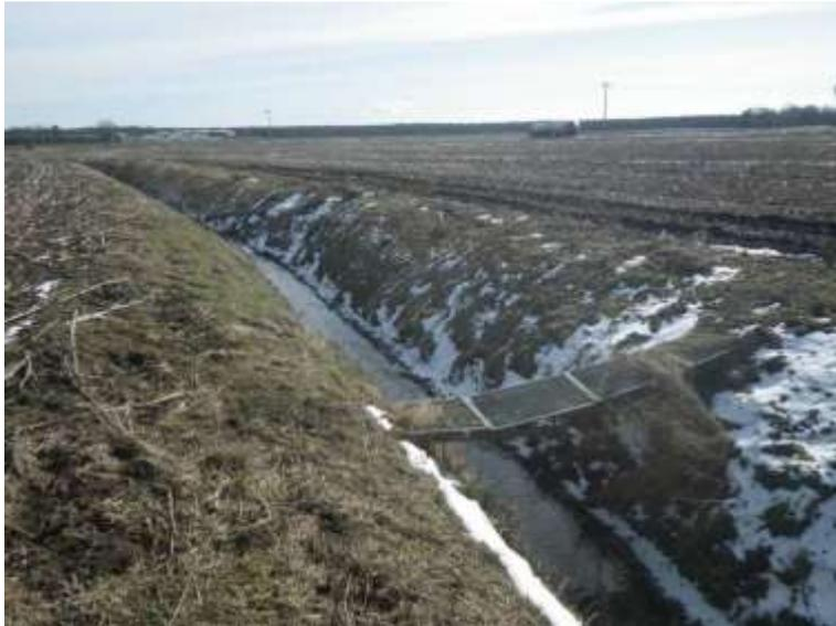
**Abbildung 38:** Lehmkuhlengraben bei km 19+300, starke Eintiefung und gleichförmiges Profil
