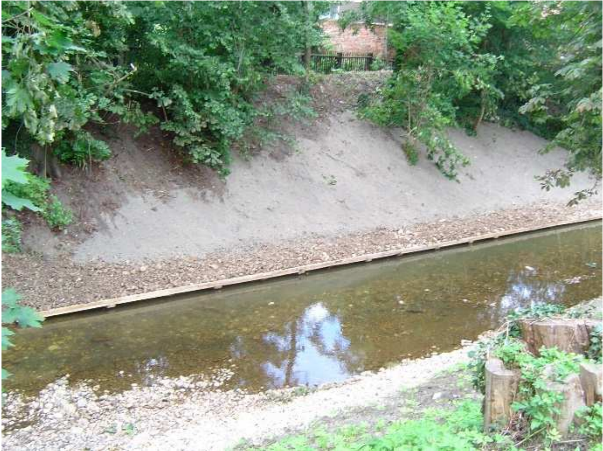
Foto 44: Hedingkehlbuhne im Bauzustand
