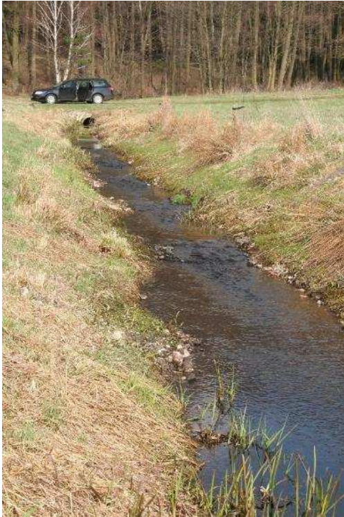
Foto 46: Sohlssicherung an einer geöffneten Verrohrung in Form einer Rausche – Kolk – Gestaltung aus Kiessubstrat
