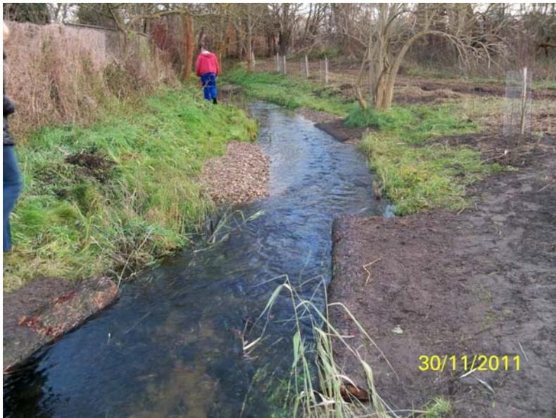
Abb. 8: Einbau von Baumstämmen und Kies zur Strömunglenkung
