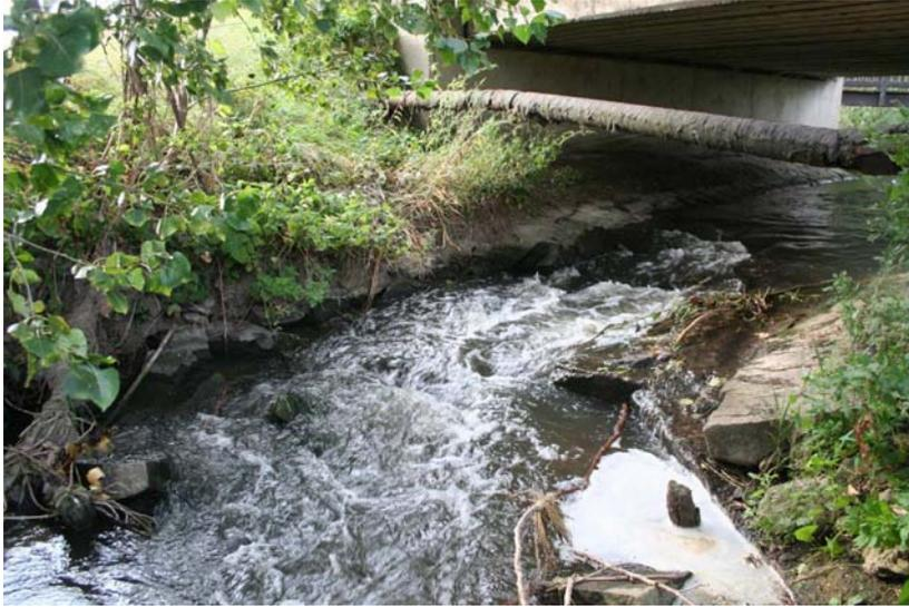
Abb. 4: Straßenbrücke der B246, zerstörte Sohlsicherung
