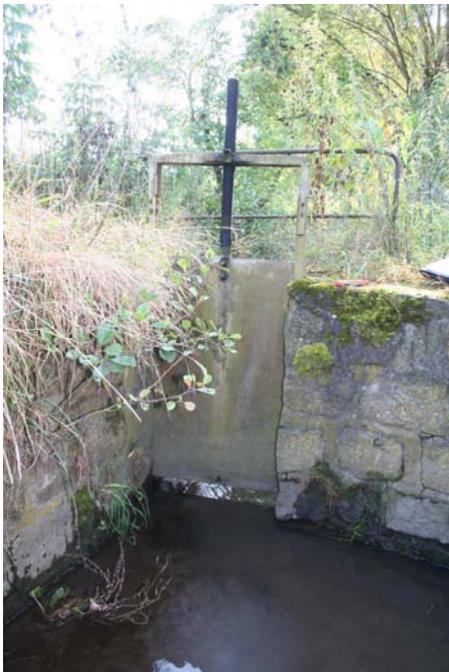
Abb. 5: Verteilerbauwerk Stat. 12+731, geöffnete Wehrtafel in Richtung Sarre
