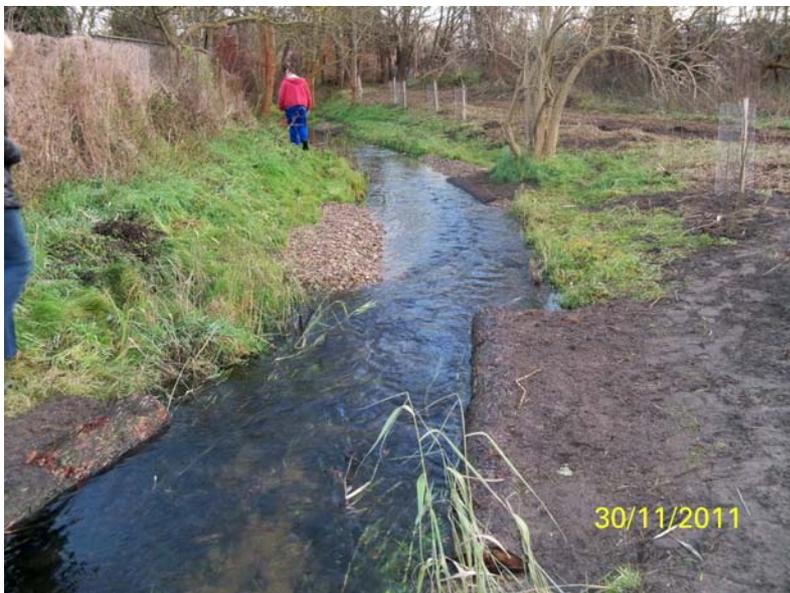
Abb. 11: Einbau von Baumstämmen und Kies zur Strömungsumlenkung
