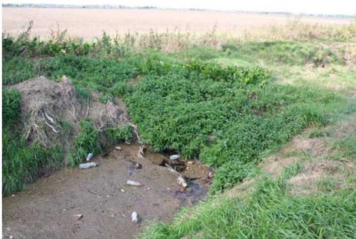
Abb. 5: Verklauster und verfallener RDL bei Stat. 1+622
