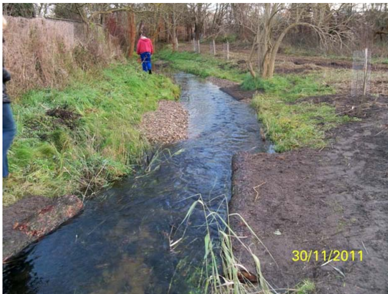
Abb. 8: Einbau von Baumstämmen und Kies zur Strömungsumlenkung
