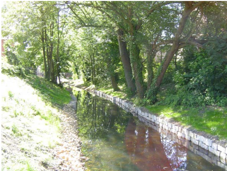
Abb. 6: Trockenmauerverbau mit Lückensystem
