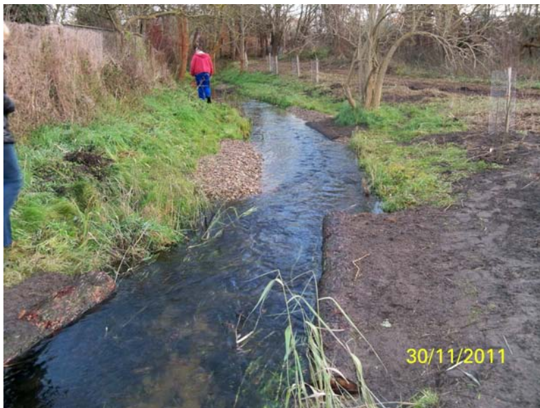
Abb. 9: Einbau von Baumstämmen und Kies zur Strömunglenkung
