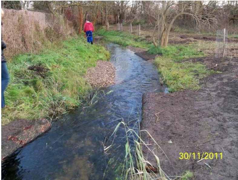
Abb. 9: Einbau von Baumstämmen und Kies zur Strömunglenkung
