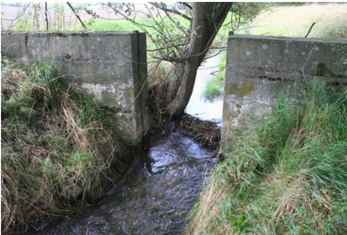
Abb. 5: Stauanlage bei Stat. 0+584
