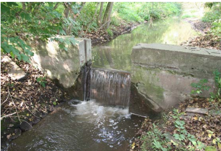
Abb. 6: Stauanlage bei Stat. 0+788, im Oberwasser befindet sich die Wasserentnahme für die Angelteiche
