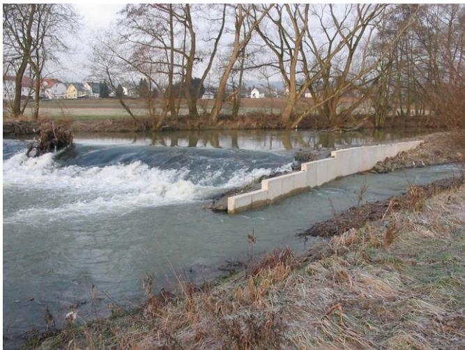
Abb. 8: Raugerinne mit Beckenstruktur und hydraulischer Trennwand [4]
