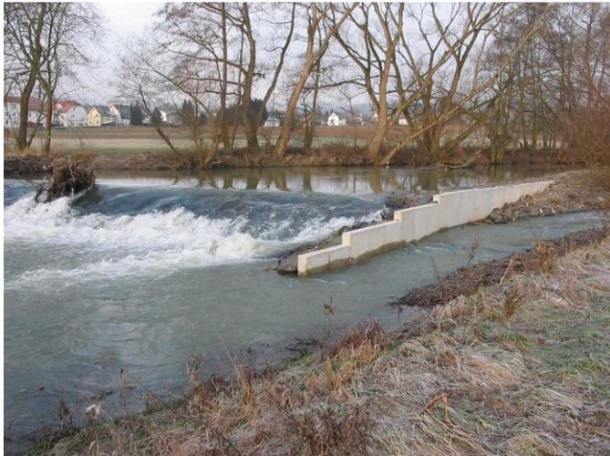
Abb. 6: Raugerinne mit Beckenstruktur und hydraulischer Trennwand [4]
