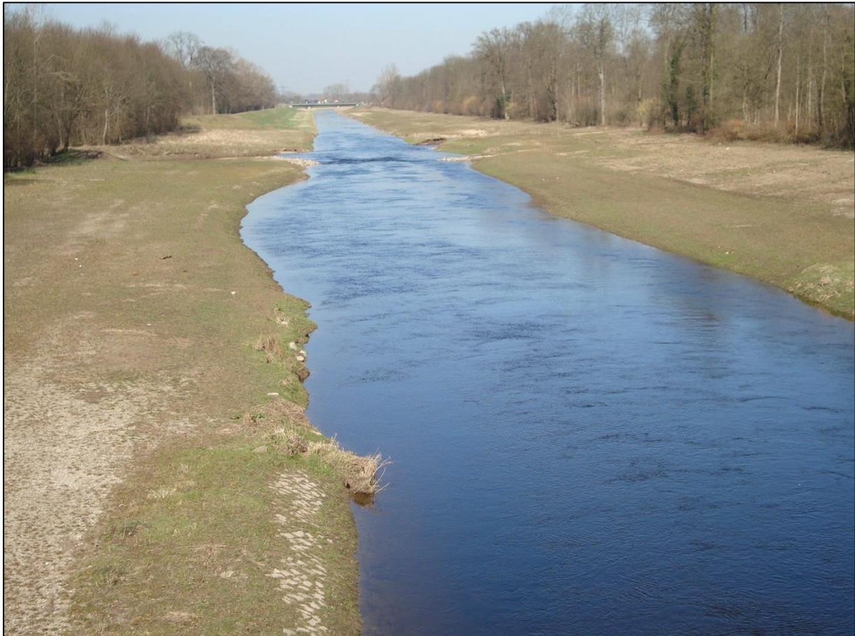
Abb. 6: Entfernung von Laufsicherungen für eigendynamische Entwicklungen des Gewässers [5]
