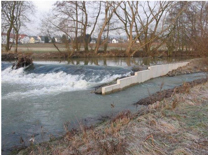
Abb. 5: Raugerinne mit Beckenstruktur und hydraulischer Trennwand [4]
