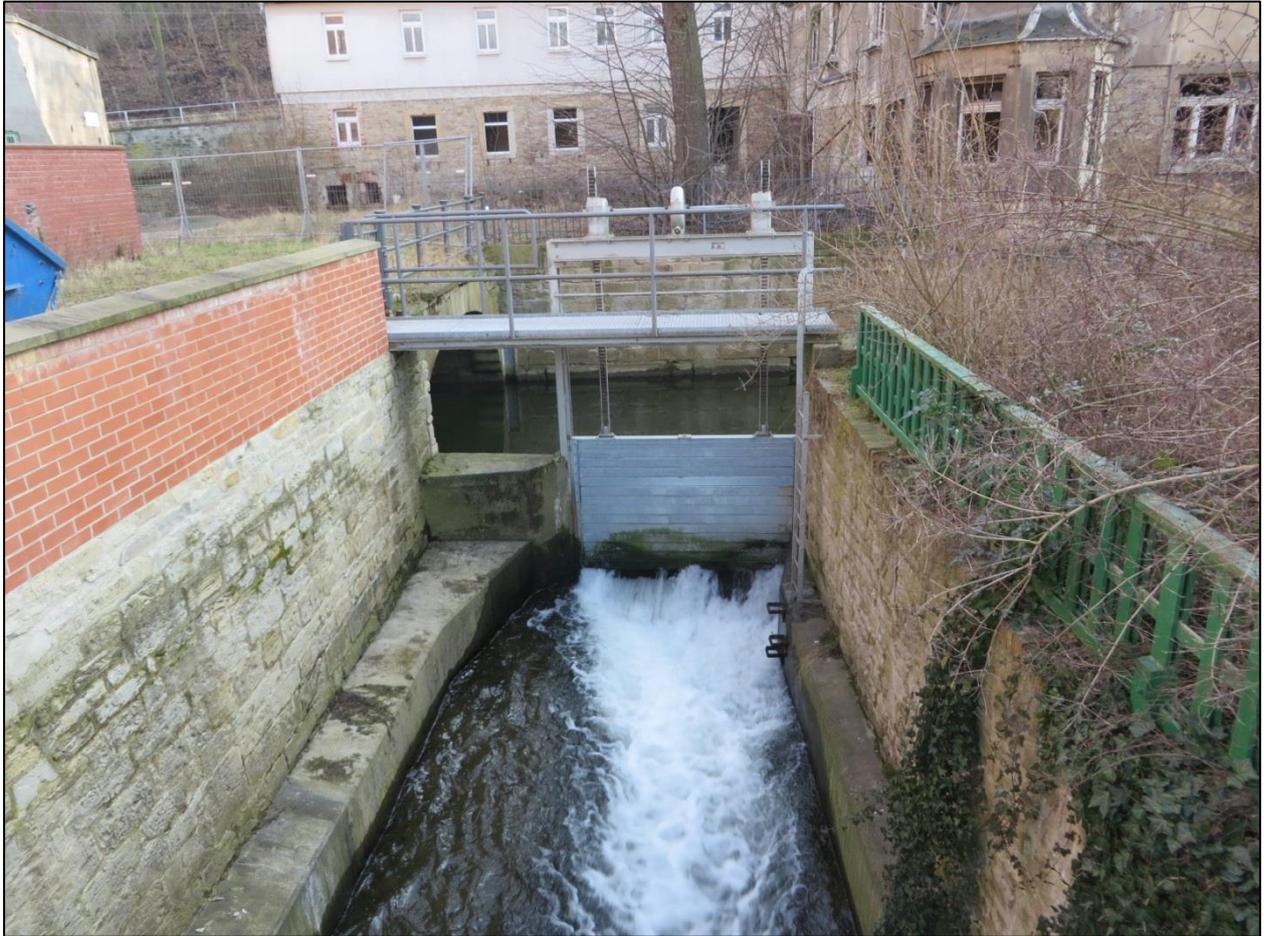
Foto 15: Schützenwehr des Mühlengrabens Zeitz zur Wasserregulierung des Nebenarms Zeitz, nicht durchgängig, Station 0+400, Aufnahmedatum: 26.02.2015
