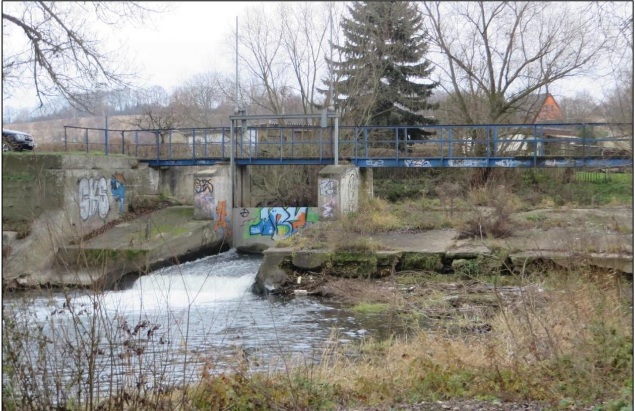
Foto 14: Stauanlage am Mühlgraben Zeitz bei Einmündung in die Weiße Elster, nicht durchgängig, Station km 4+300; Aufnahmedatum: 10.12.2014
