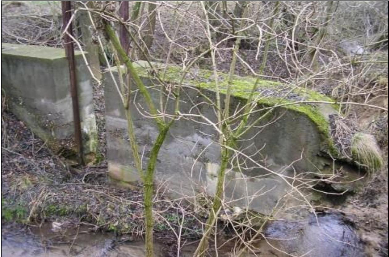
Foto 11: Stauanlage aus Beton ohne Nutzung, nicht durchgängig, Station km 1+500; Aufnahmedatum: 15.07.2010 (Fotodokumentation von Kartierung, 2010)
