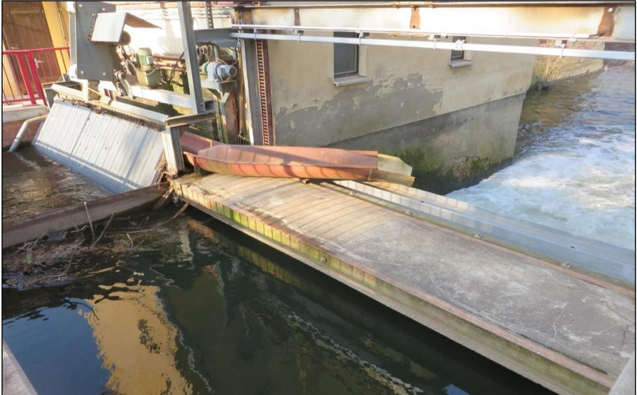
Foto 13: Stauanlage am Mühlgraben Göbitz, nicht durchgängig, Station km 0+600; Aufnahmezeitpunkt: 16.02.2015
