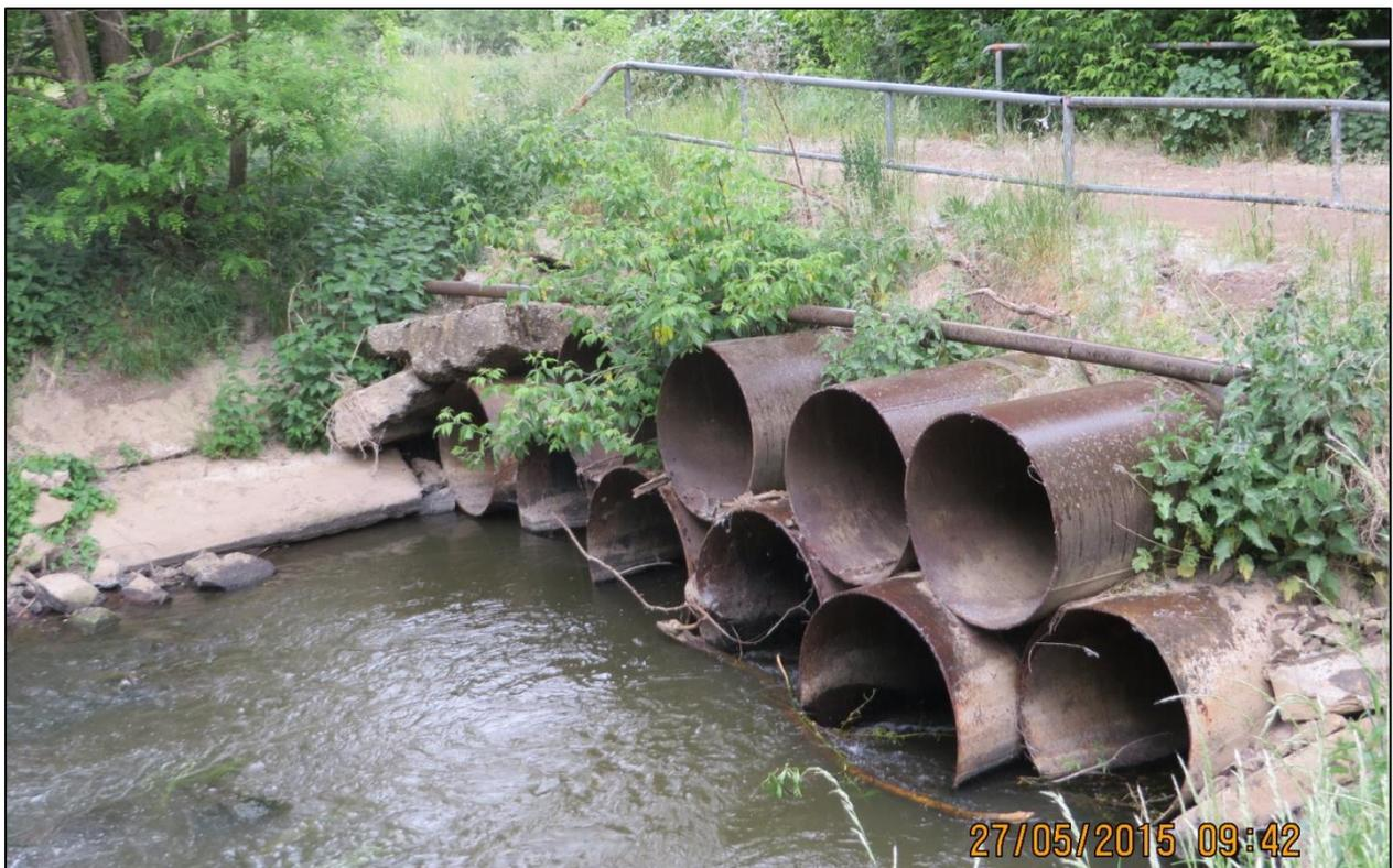
Foto 12: Durchlass aus 10 Rohren in Betonfassung, nicht durchgängig, Station km 1+100; Aufnahmedatum: 27.05.2015
