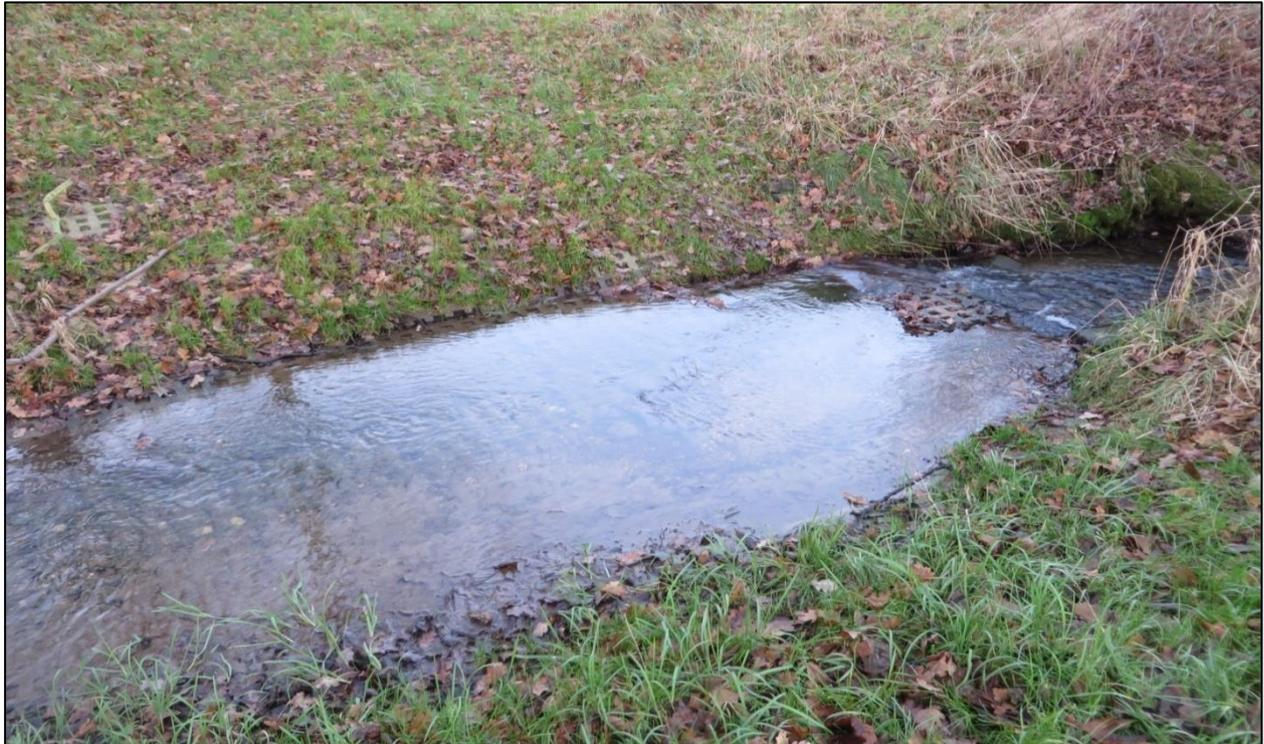
Foto 10: Furt aus Rasengittersteinen, nicht durchgängig, Station km 0+500; Aufnahme am 17.12.2014
