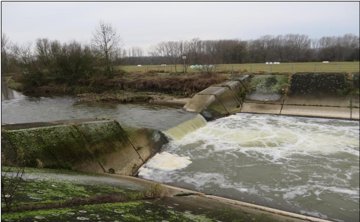
Foto 4: Sohlbauwerk zwischen Profen und Löbnitz-Bennewitz, nicht durchgängig, Station km 1+100; Aufnahmedatum: 12.12.2014
