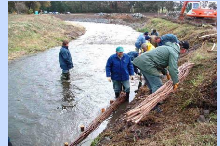
Unterhaltungsarbeiten am Gewässer
